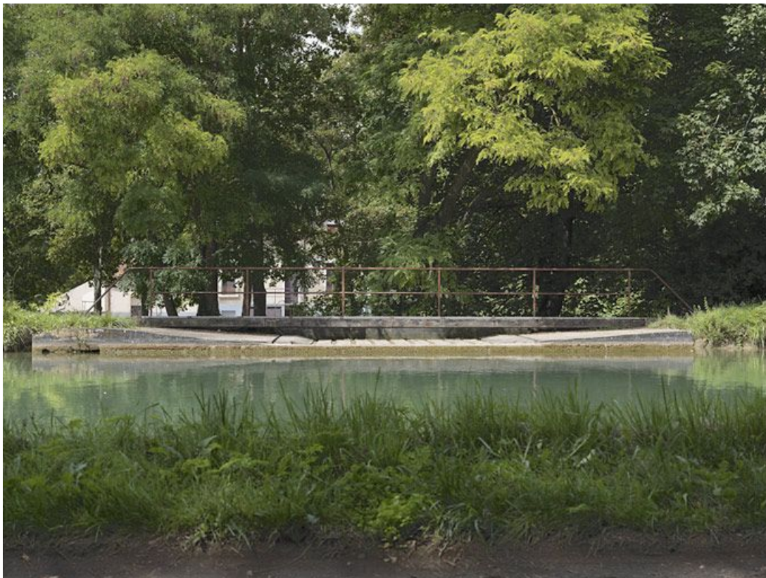
Détail du chemin de halage qui est prolongé par une passerelle métallique avec la maçonnerie du déversoir de superficie rive droite.
