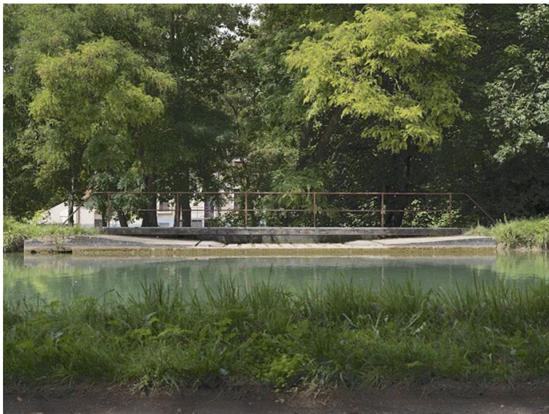
Détail du chemin de halage qui est prolongé par une passerelle métallique avec la maçonnerie du déversoir de superficie rive droite.
