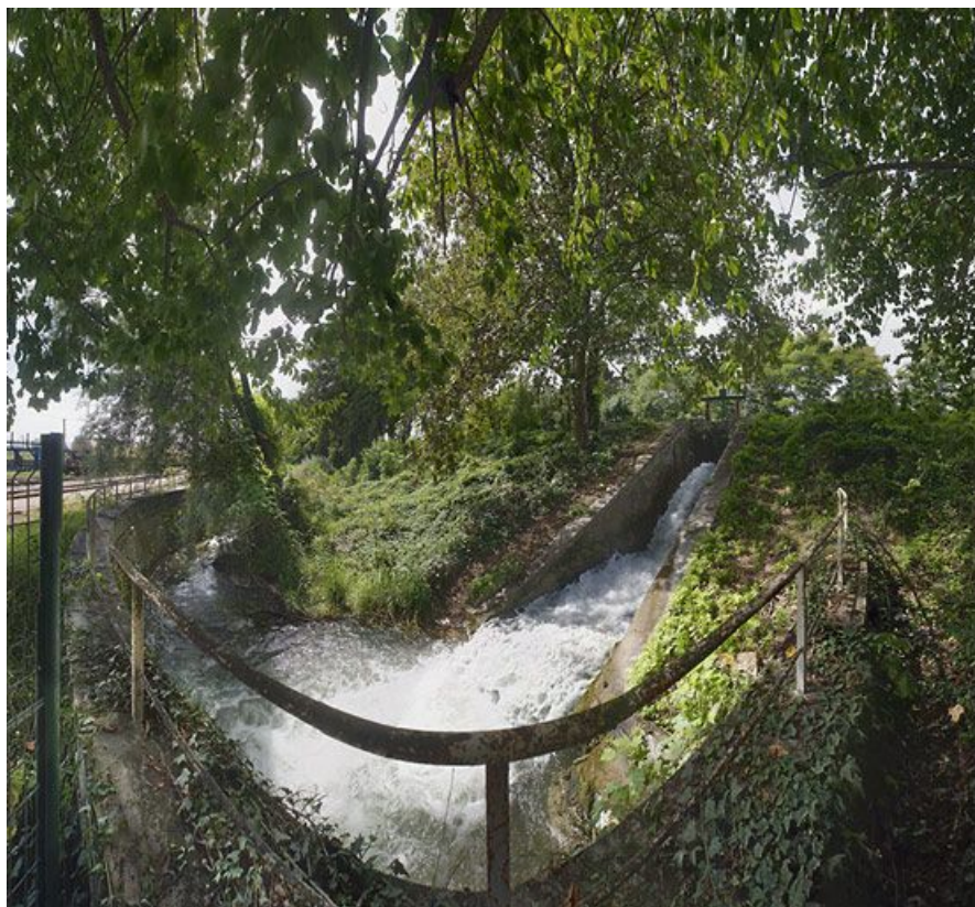
Vue d'ensemble de la rigole d'évacuation et de la vanne du déversoir de fond.
