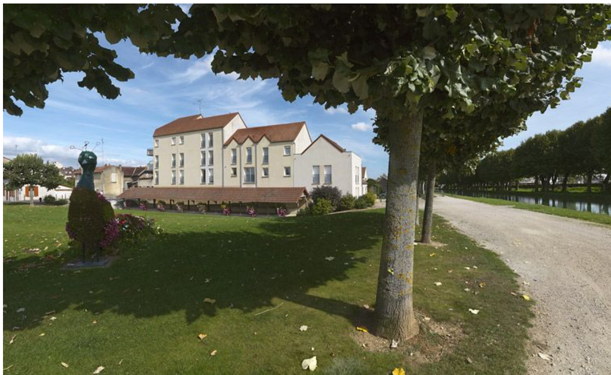
Vue d'ensemble : on voit nettement que le lavoir à gauche est en contrebas du canal, à droite de l'image. 89, Migennes, lieudit : bief 114-115 du versant Yonne
