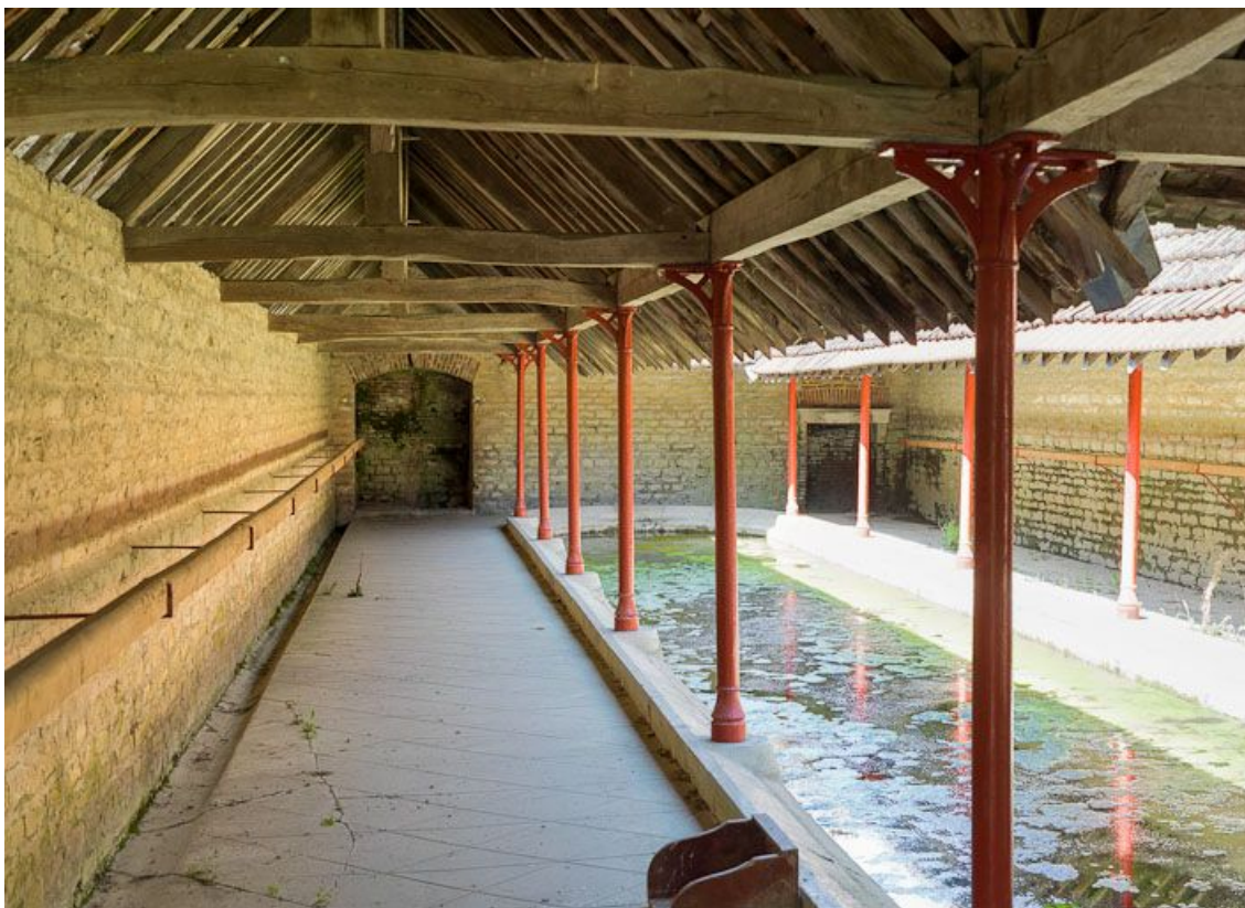
Vue de l'intérieur et des colonnes en fonte soutenant la toiture en impluvium.
