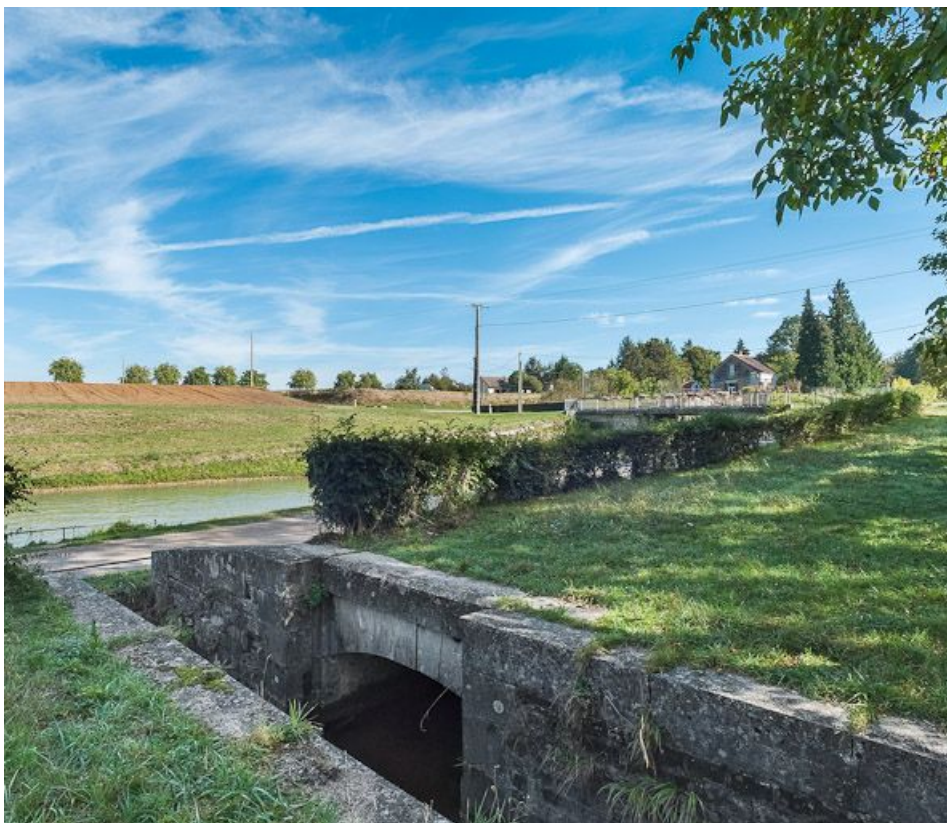
Détail de la maçonnerie de l'ancienne prise d'eau dans la rigole. Ecluse en arrière-plan.
