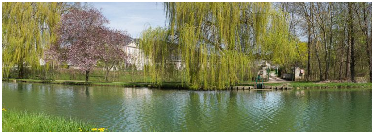
Le château pris de la rive gauche. On aperçoit la vanne d'une rigole du parc du château. 89, Cheney, lieudit : bief 98 du versant Yonne
