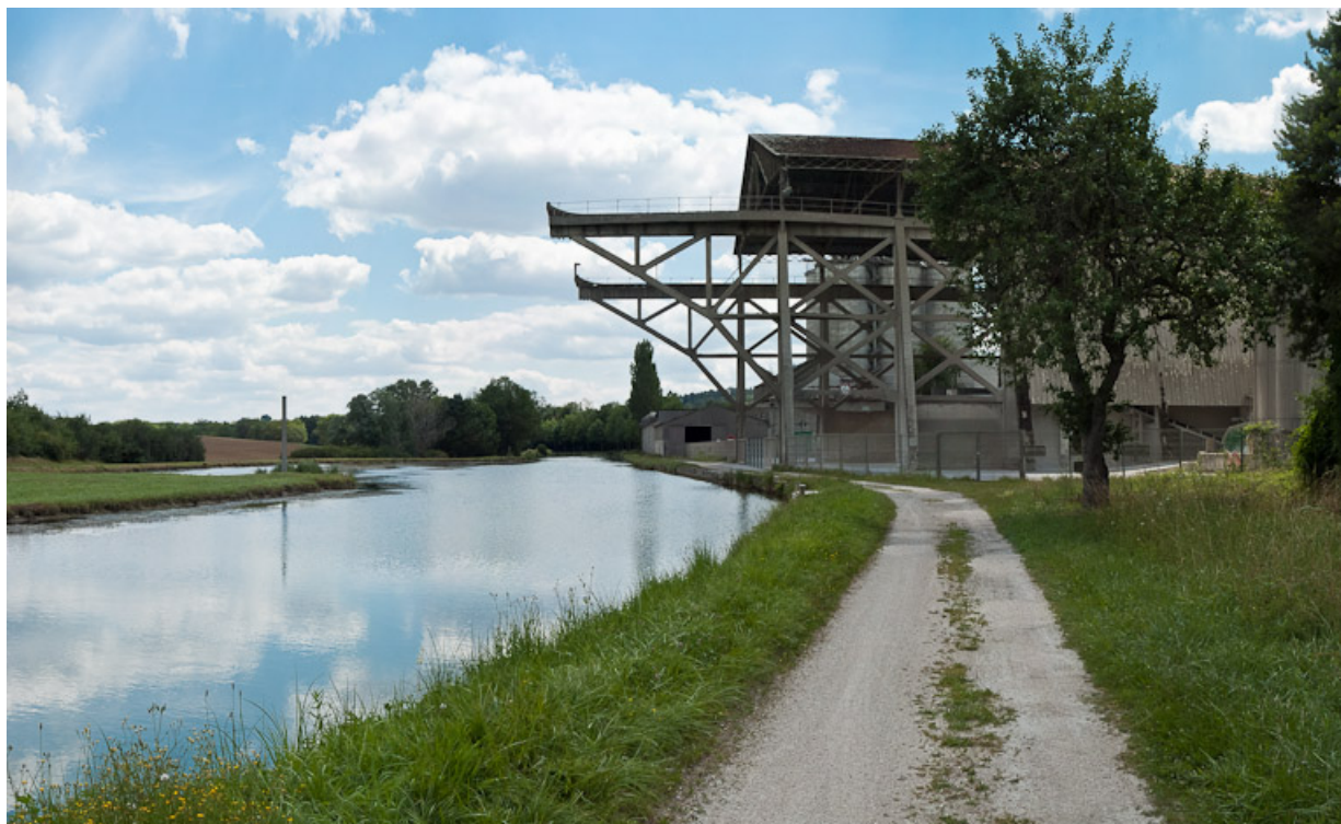
Vue de la cimenterie donnant sur la gare d'eau. 89, Lézennes, lieudit : Frangey
