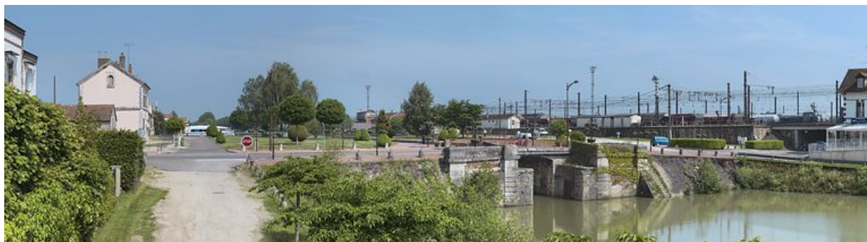
Grand panorama sur l'avant-port. De gauche à droite : le site d'écluse, port, le site SNCF.
