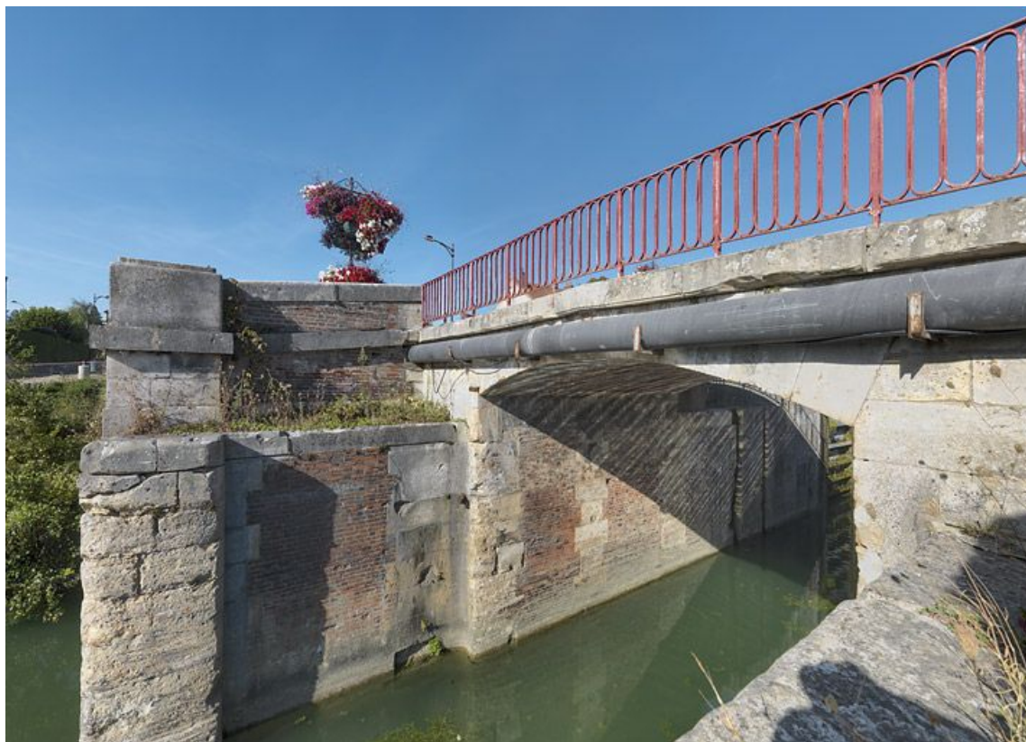
Le pont sur écluse : détail des maçonneries avec l'échelle de crues.
