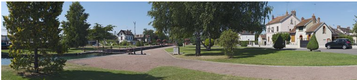
Panorama sur le site de l'écluse 114-115 du versant Yonne, dite de Laroche, à Migennes. De gauche à droite : site d'écluse, maisons de garde et de perception.
