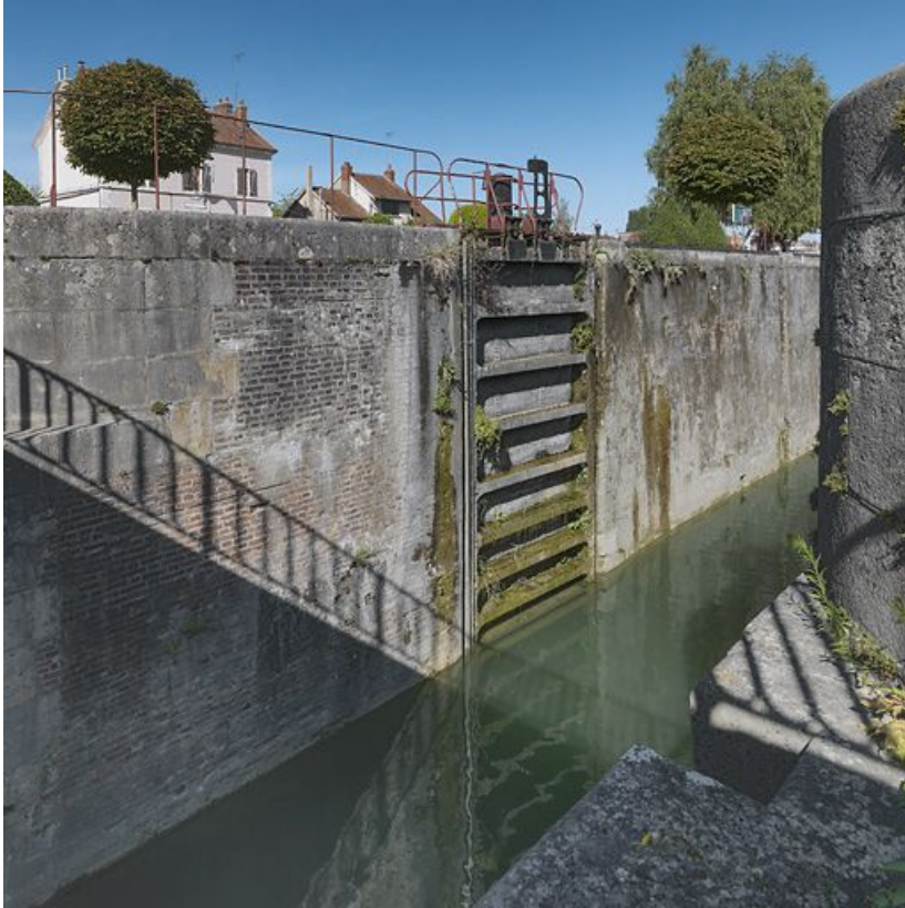
Site d'écluse vu d'amont : bajoyer en brique.
