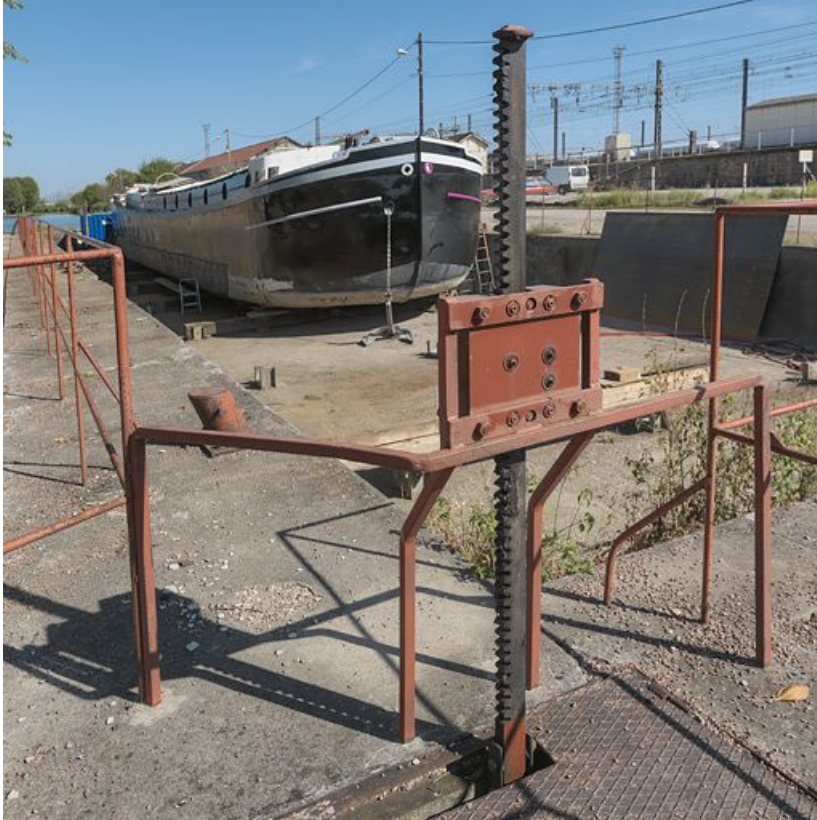
La cale sèche. Détail des vannes.
