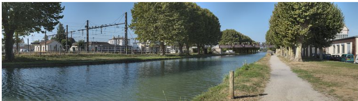
Panorama du canal traversant Migennes en direction de l'Yonne. A gauche, le site SNCF et la gare, la passerelle menant à la gare.
