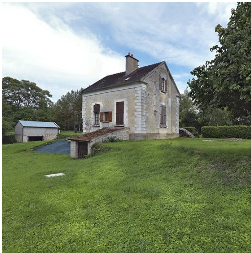
Maison éclusière : vue de 3/4 arrière.
