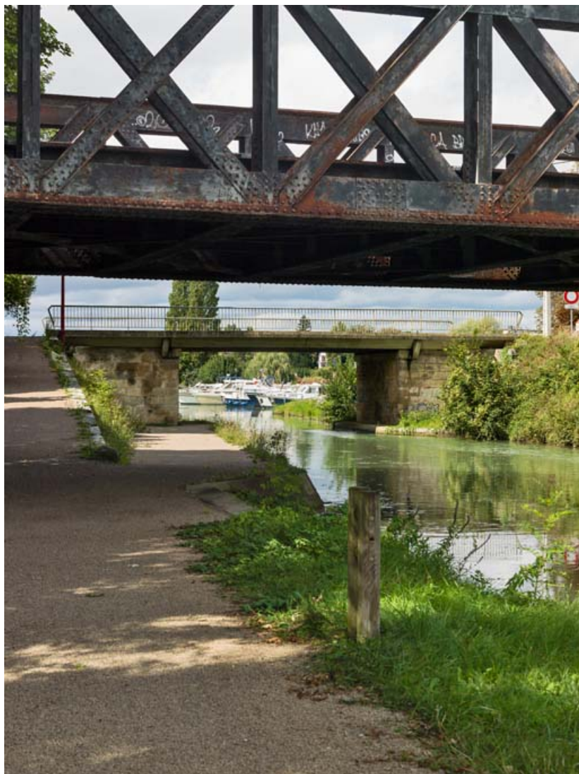
Vue d'ensemble du pont avec le pont ferroviaire en premier plan.
