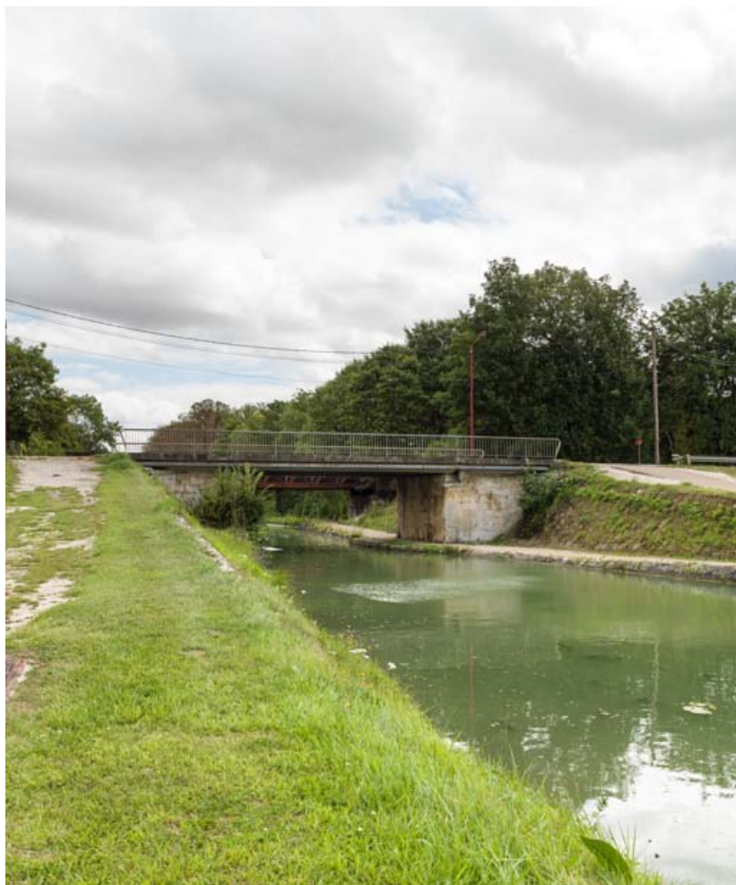
Vue d'ensemble du pont au premier plan et du pont ferroviaire en arrière plan. 89, Saint-Florentin, lieudit : bief 108 du versant Yonne
