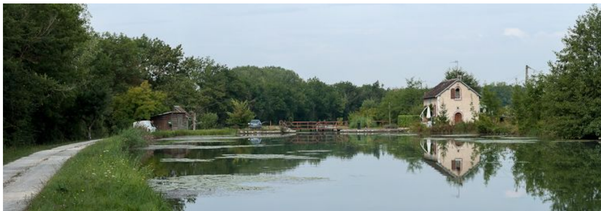
Vue d'ensemble du site d'écluse, avec à droite, la maison éclusière.
