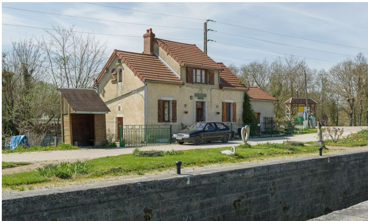
Vue d'ensemble de la maison éclusière, vue de 3/4.
