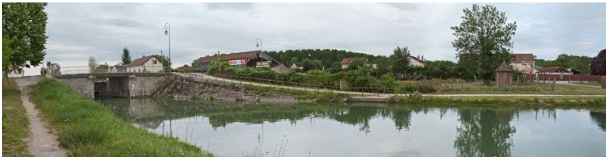
Vue du pont sur écluse et de l'arrivée de la rigole d'alimentation.
