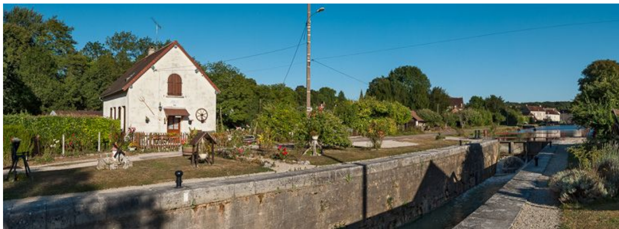
Vue d'ensemble du site d'écluse, avec à gauche, la maison éclusière.
