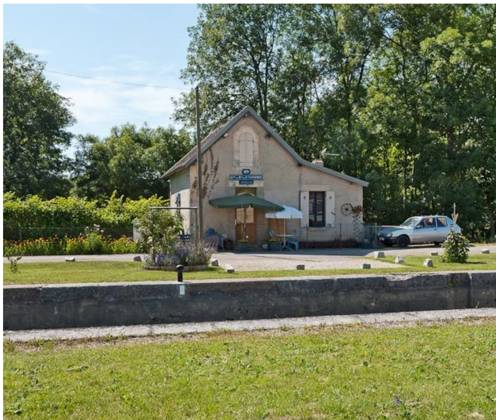
Vue de face de la maison éclusière.
