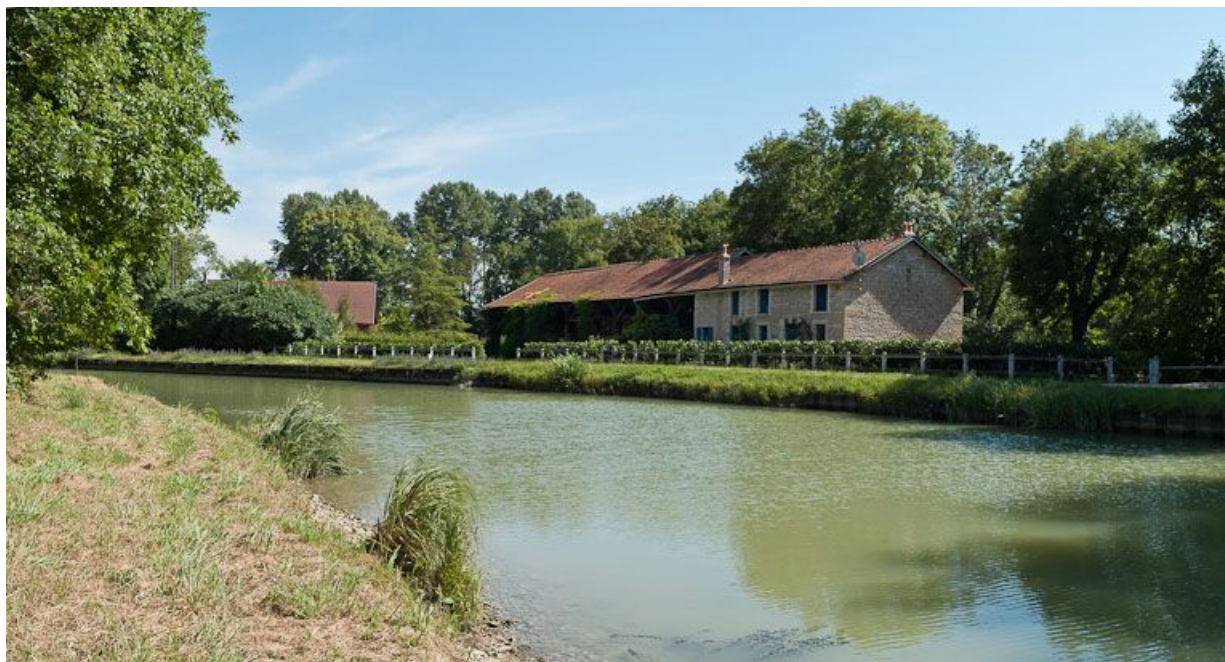
Vue de l'ancien moulin situé en amont du site d'écluse.
