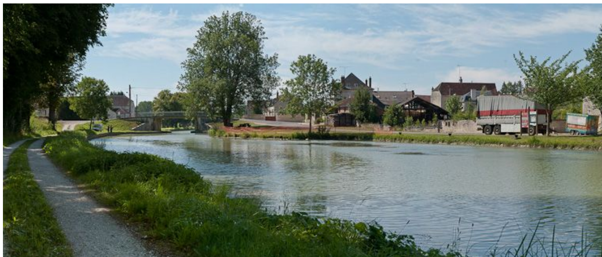
Vue du port au premier plan et du pont à l'arrière-plan.
