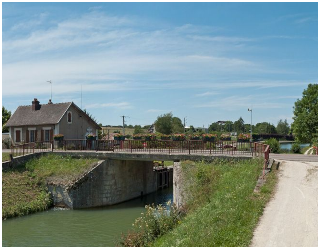
Vue du pont sur écluse au premier plan et de la maison de garde à gauche.
