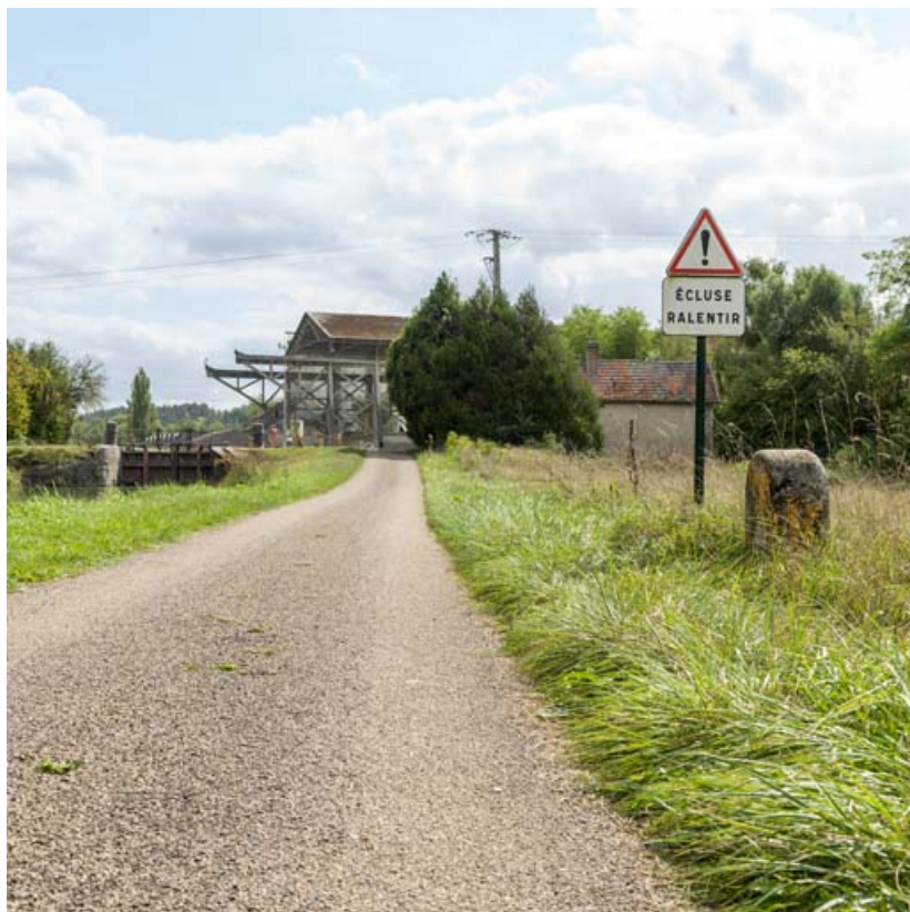
Vue d'ensemble de l'écluse, du chemin de halage et de la borne.
