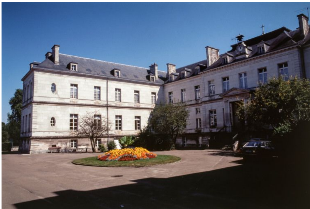
Cour et vue d'ensemble des façades.
