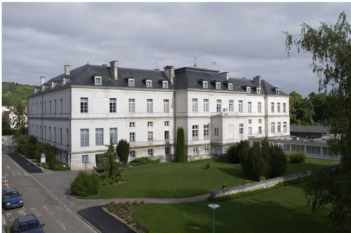
Pavillon Dormois : vue d'ensemble de la façade postérieure.
