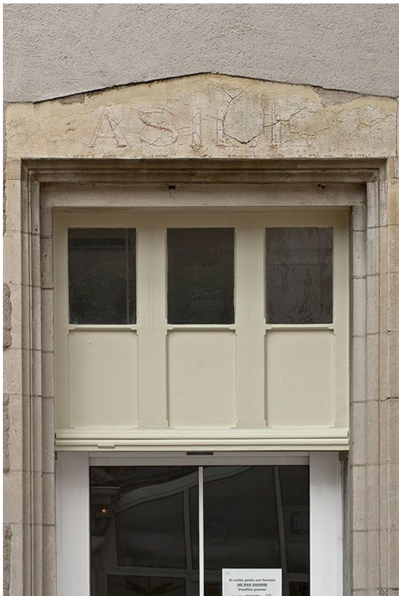
Détail de l'encadrement de la porte d'entrée de la façade sud du bâtiment de l'angle nord-est. 89, Villeneuve-sur-Yonne, 87-89 rue Carnot
