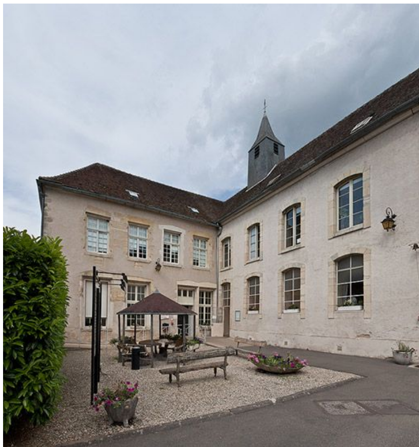
Angle de la cour formé par la façade sud du bâtiment nord-est et celle du bâtiment est. 89, Villeneuve-sur-Yonne, 87-89 rue Carnot
