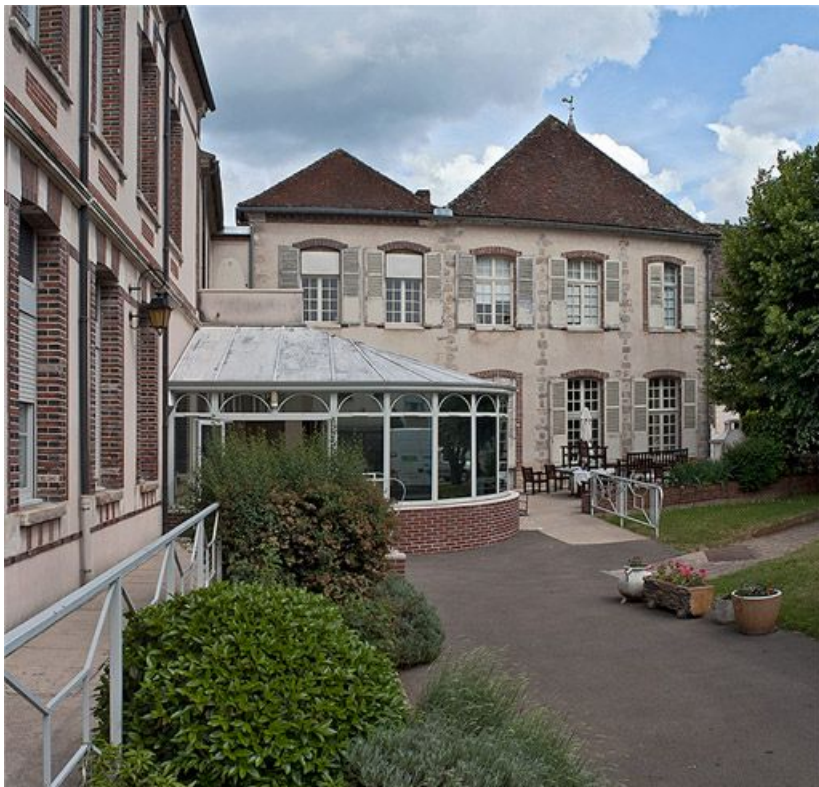
Façade sur cour du bâtiment situé dans l'angle nord-est.
