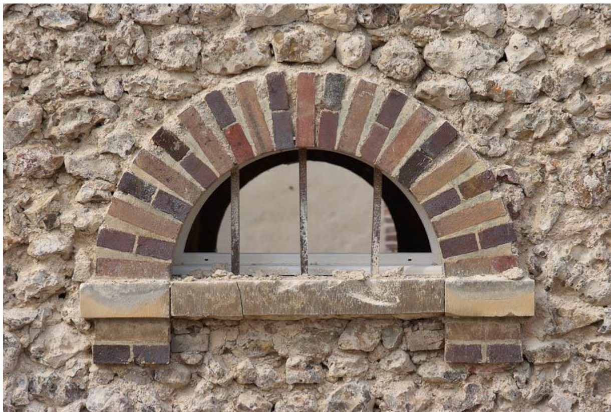
Baie semi-circulaire du mur-pignon du bâtiment à gauche du portail d'entrée.
