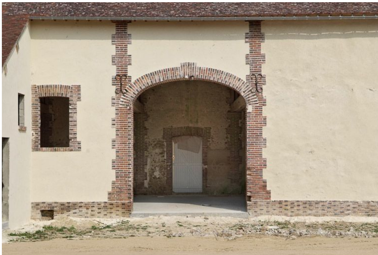
Bâtiment avec appentis à gauche dans la cour, porte charretière.
