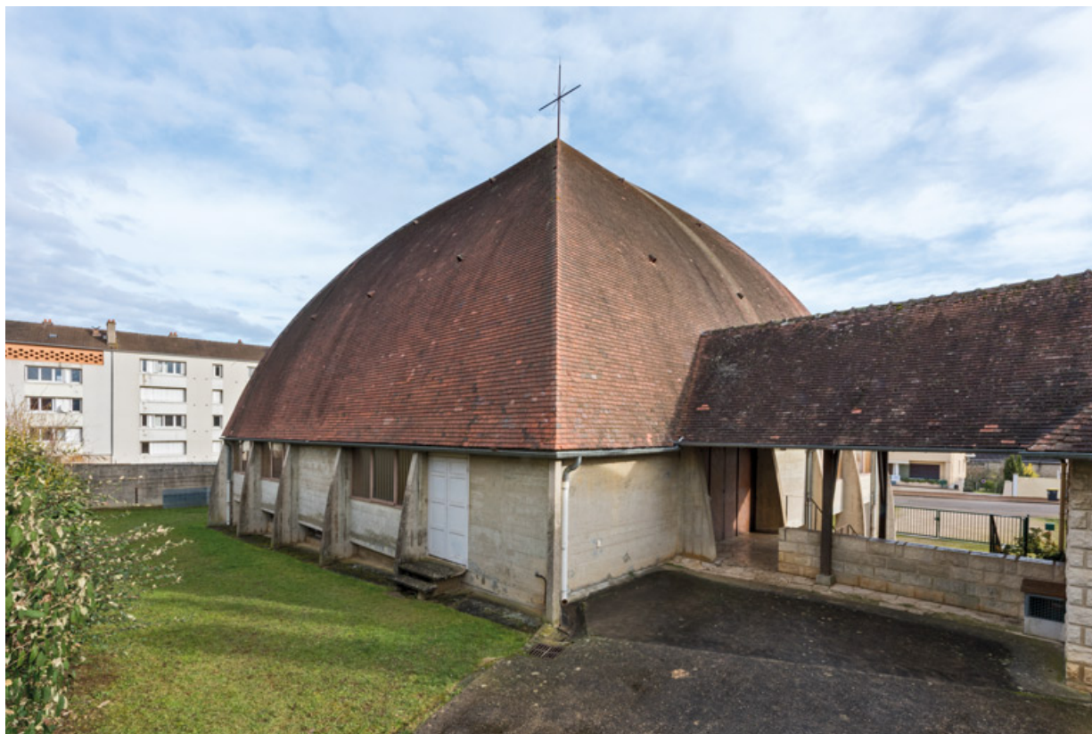
Eglise et son porche. Vue de trois quarts depuis l'est.
