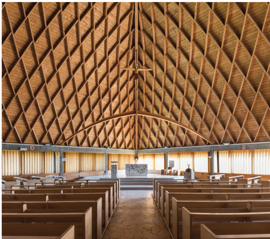
Chœur. Vue depuis l'allée centrale.
