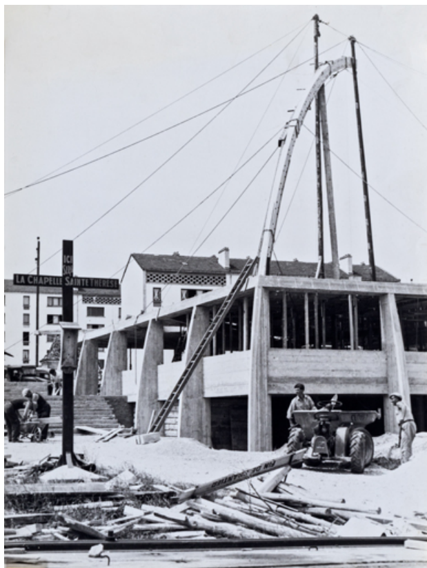
Église Sainte-Thérèse en construction, 1958. 89, Auxerre, 15 avenue 4ème régiment d'infanterie
