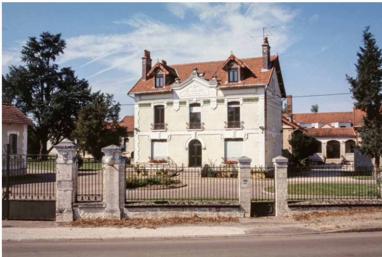
Bâtiment de l'administration, vue prise de la rue.
