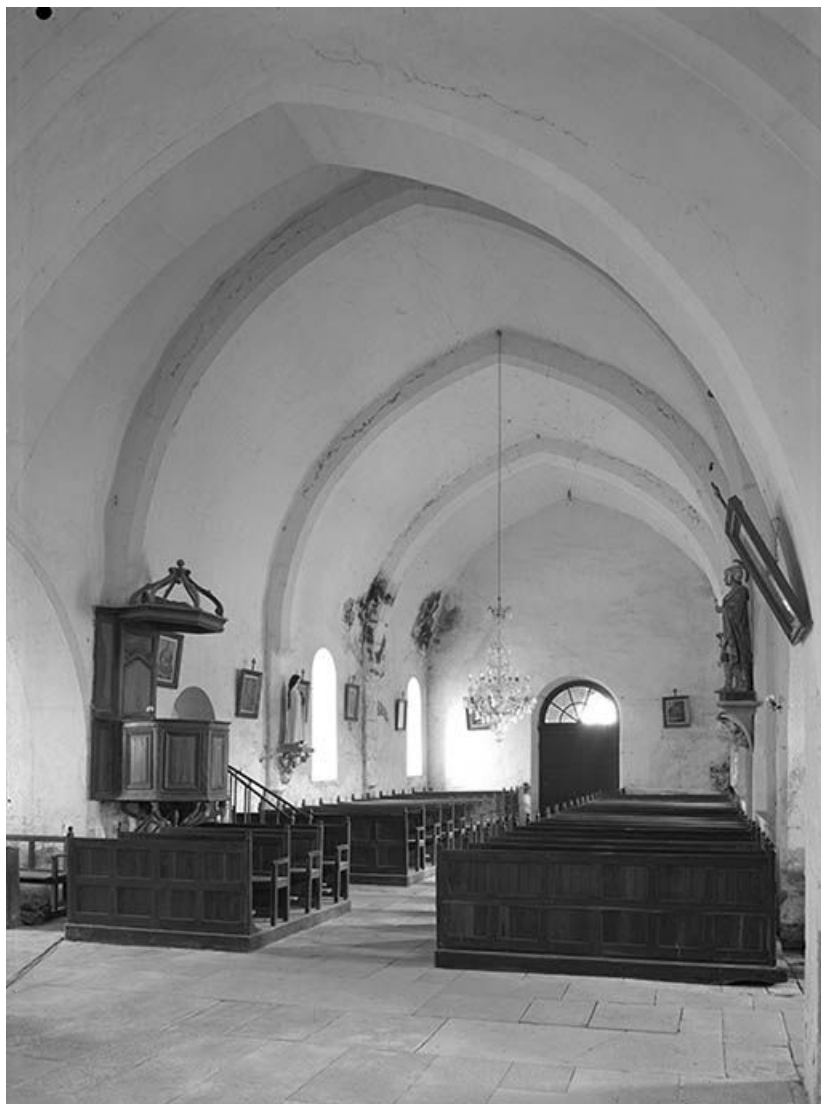
Vue est-ouest de la nef, chaire à prêcher et voûte d'ogives.
