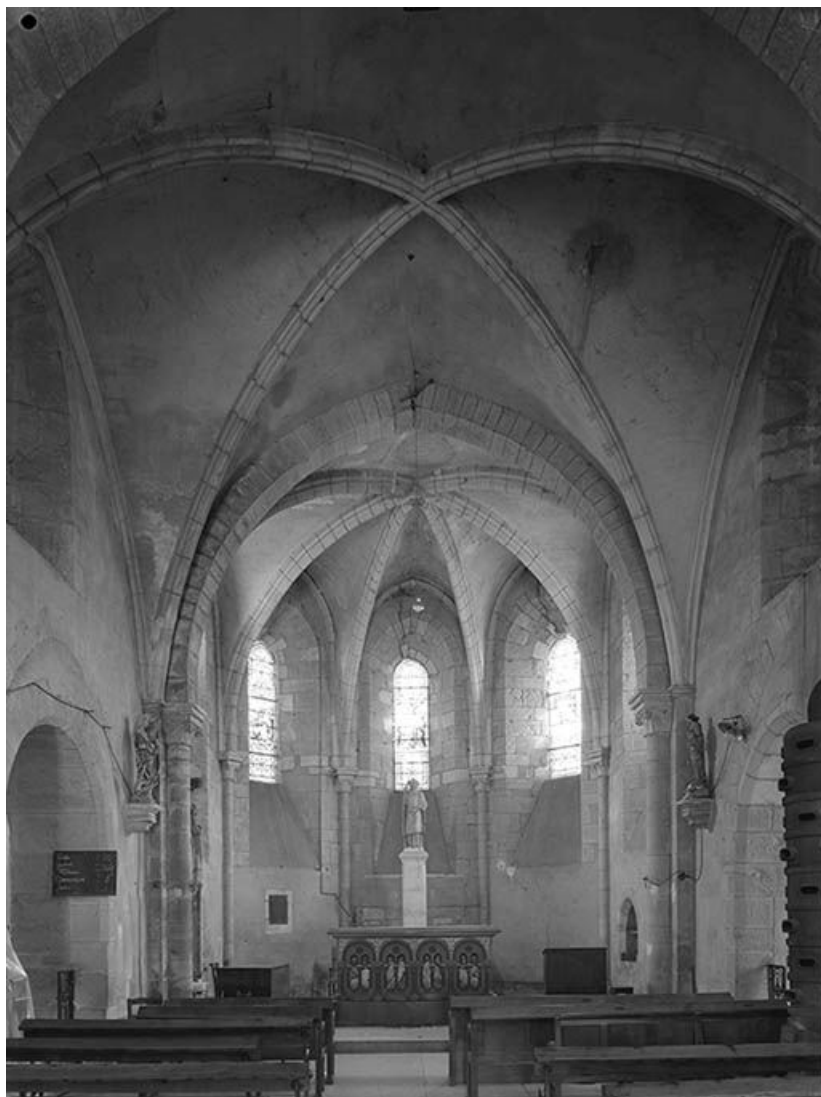
Vue intérieure vers le chœur, voûte d'ogives.
