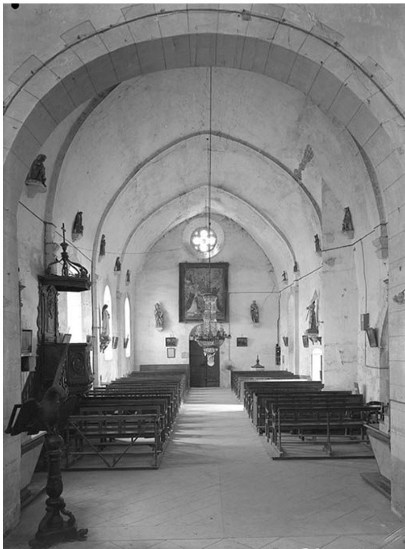
Vue est-ouest de la nef (?), à voûte en berceau brisé. 89, Cry rue du Moulin
