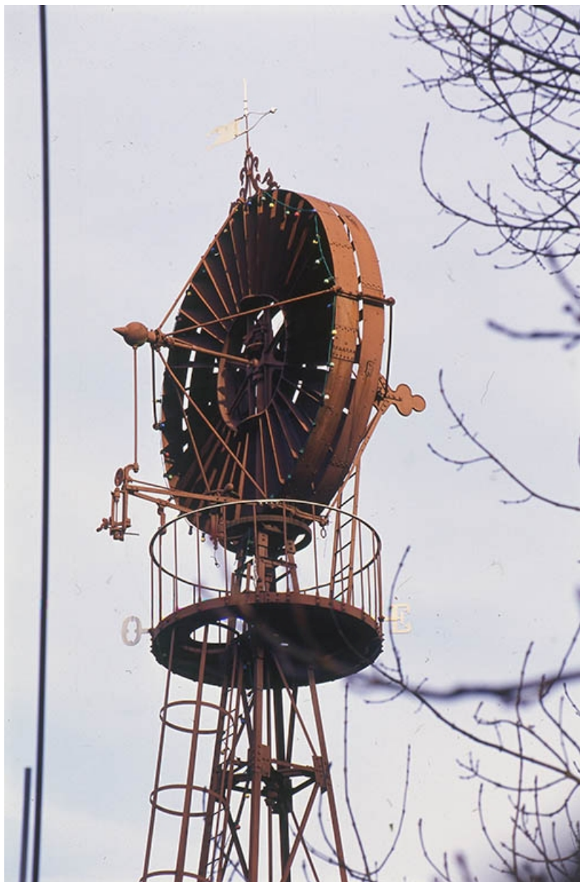
Détail : la passerelle sommitale et l'aéromoteur.
