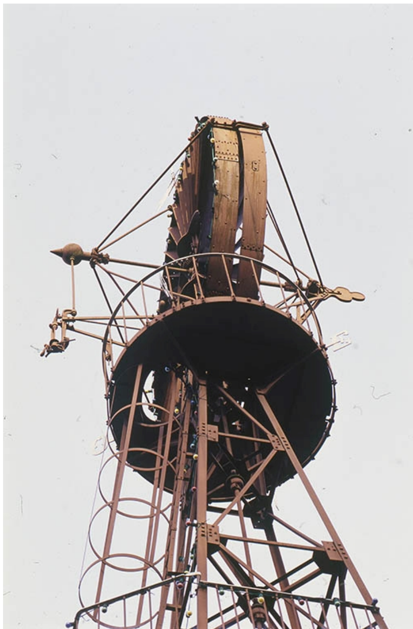
Détail : la passerelle sommitale et l'aéromoteur, vus en contre-plongée. 89, Vaudeurs Eolienne
