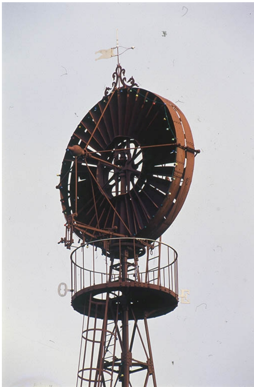
Détail : la passerelle sommitale et l'aéromoteur.
