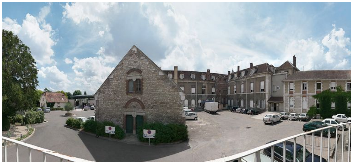
Petite construction, vestige du 1er hôpital : mur-pignon nord. 89, Joigny quai de l'Hôpital
