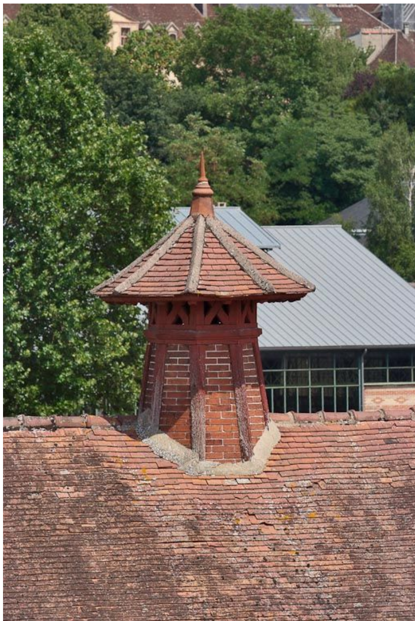
Bâtiment à gauche de l'entrée de la cour : détail de la souche de cheminée de ventilation. 89, Joigny quai de l'Hôpital
