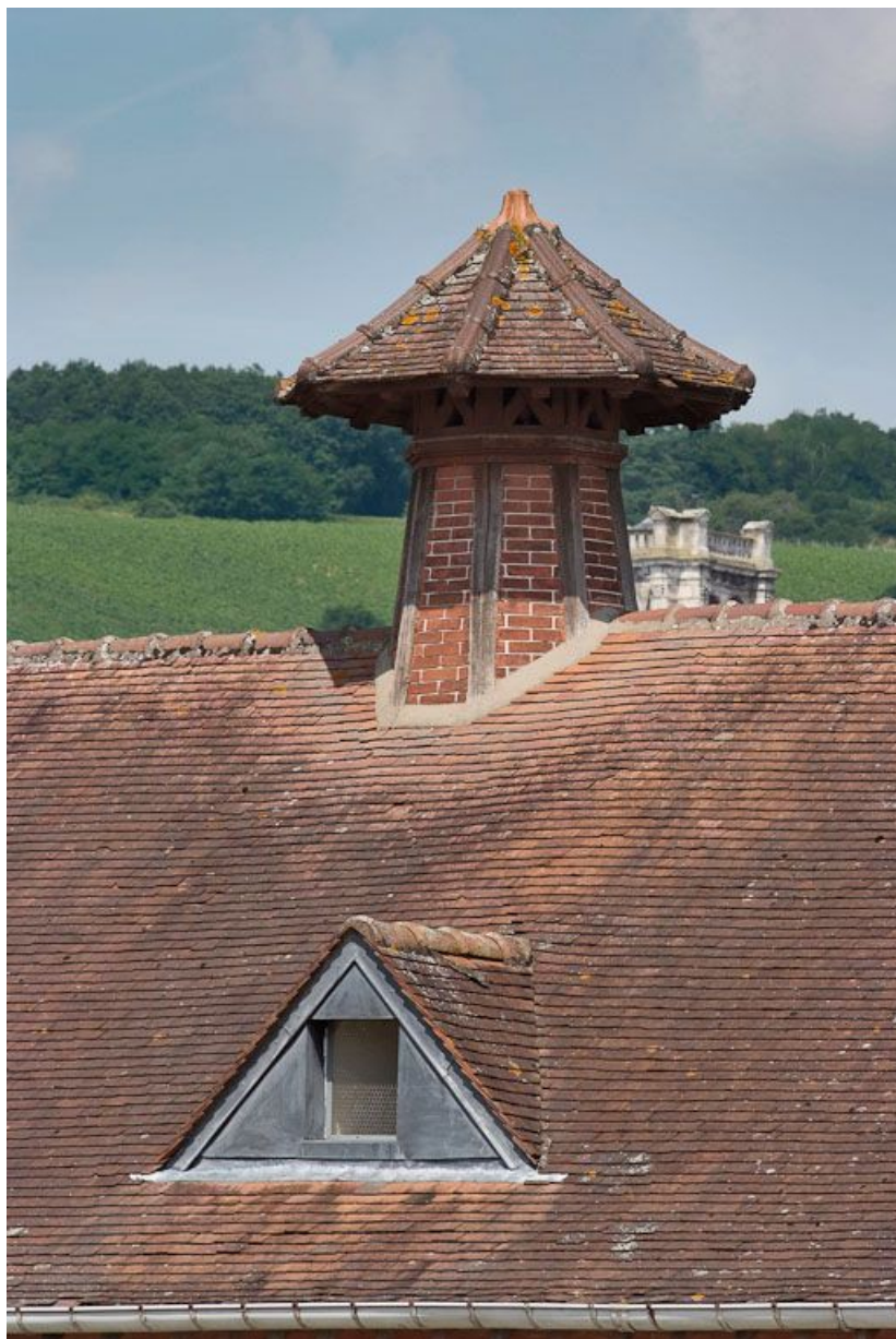
Bâtiment à droite de l'entrée de la cour : détail de la 2e souche de cheminée de ventilation. 89, Joigny quai de l'Hôpital
