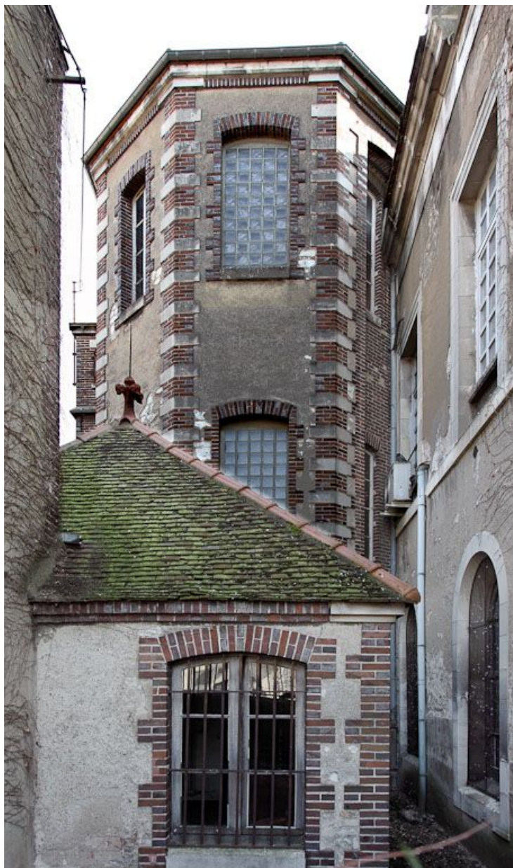
Sacristie et bâtiment hors-oeuvre de l'escalier.
