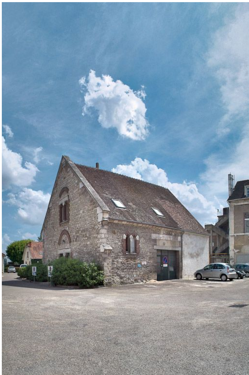
Petite construction, vestige du premier hôpital.
