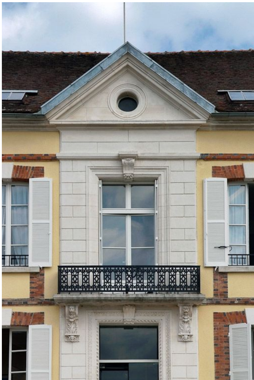
Travée centrale de la façade du bâtiment principal, détail.
