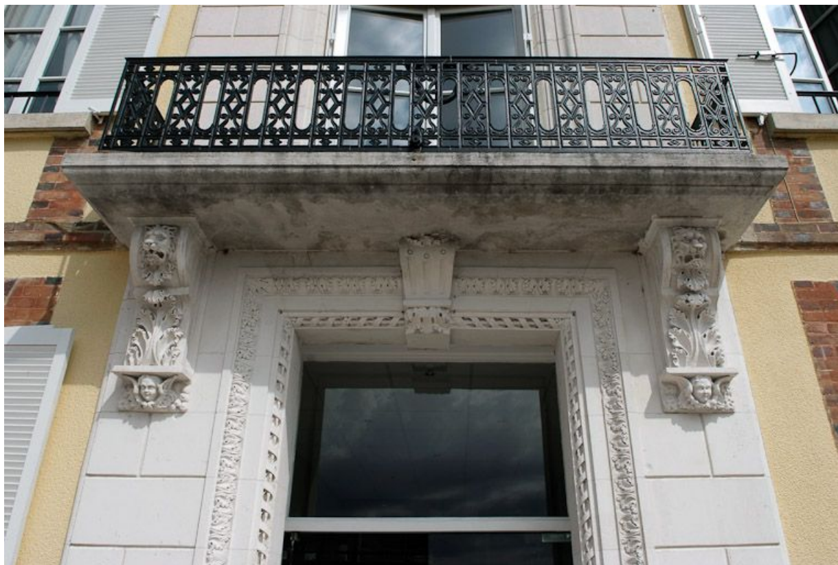
Façade du bâtiment principal : détail du balcon.
