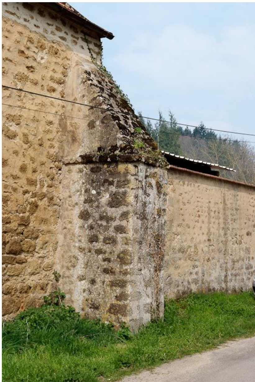
Chapelle : troisième contrefort du mur de long-pan sur rue. 89, Saint-Florentin, lieudit : la Maladrerie
