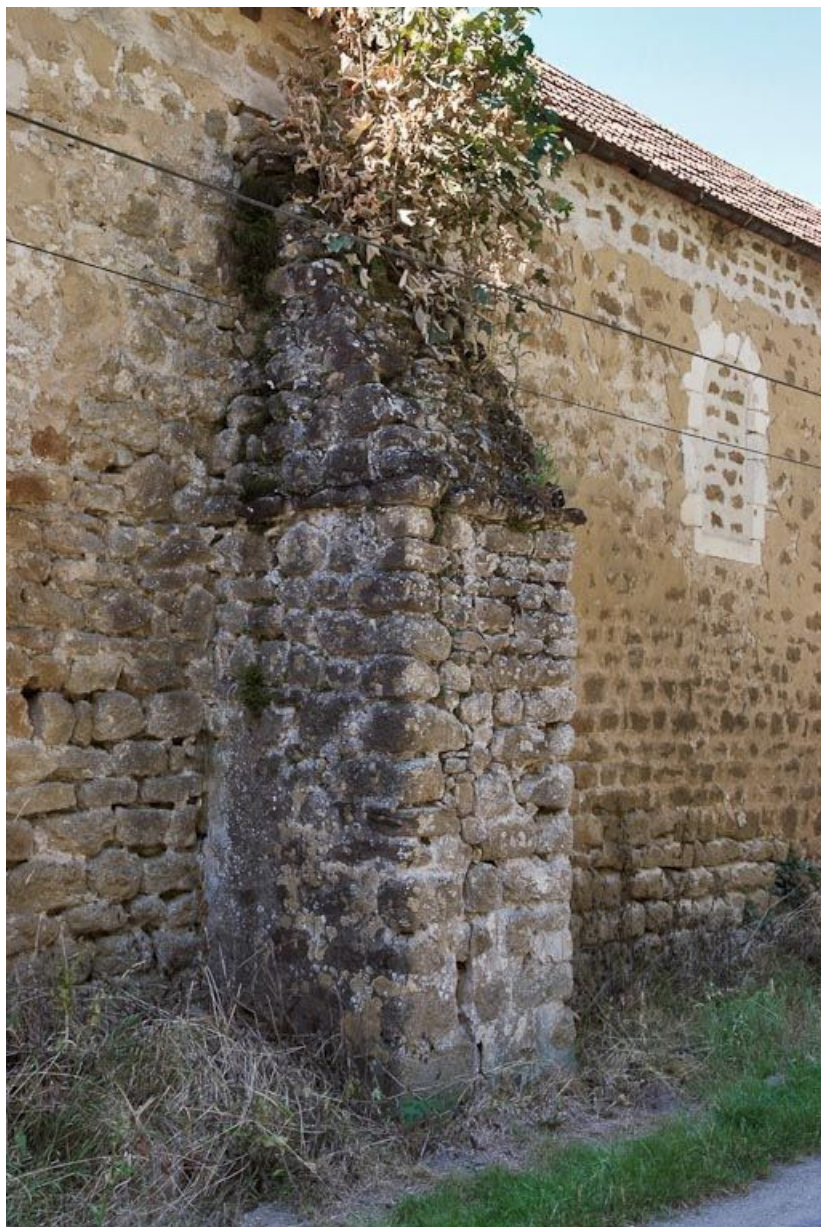
Chapelle : contrefort central du mur de long-pan sur rue. 89, Saint-Florentin, lieudit : la Maladrerie
