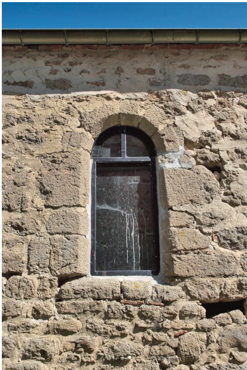
Chapelle : première fenêtre gauche du mur de long-pan sur cour. 89, Saint-Florentin, lieudit : la Maladrerie
