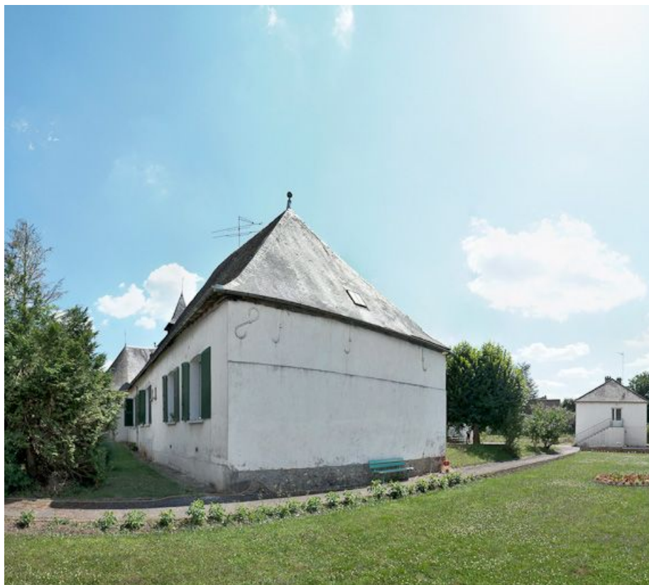
Élévation gauche du bâtiment principal et bâtiment isolé à l'ouest.
