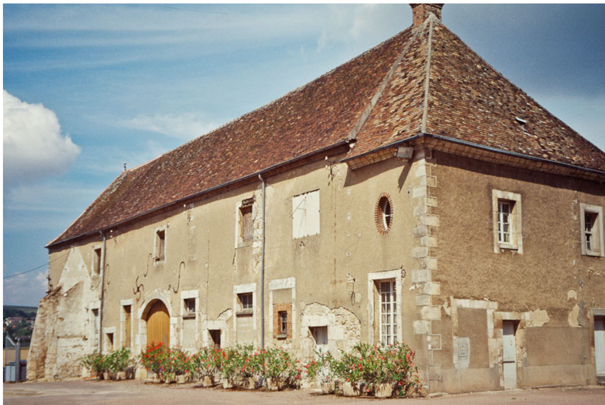
Vue du bâtiment agricole.
