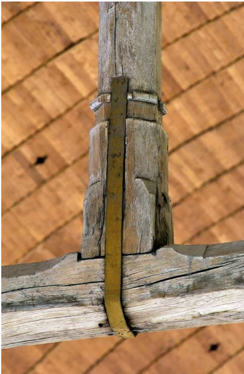
Ancienne salle des malades : poinçon de la charpente.
