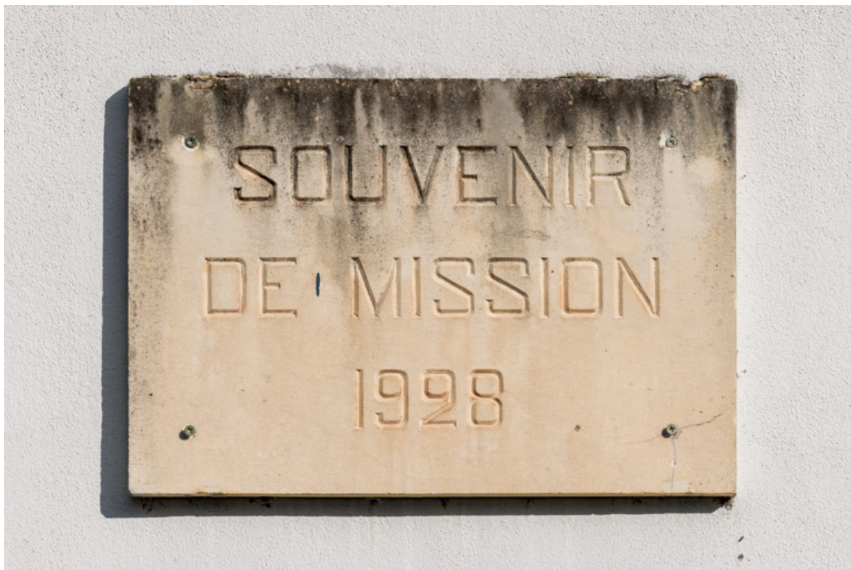
Façade latérale gauche : plaque commémorative de la mission de 1928. 71, La Clayette, 2A rue Faisant
