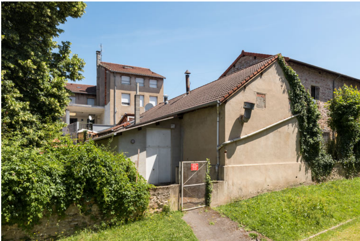
Façade postérieure, de trois quarts gauche. 71, Chauffailles, 50 rue Centrale
