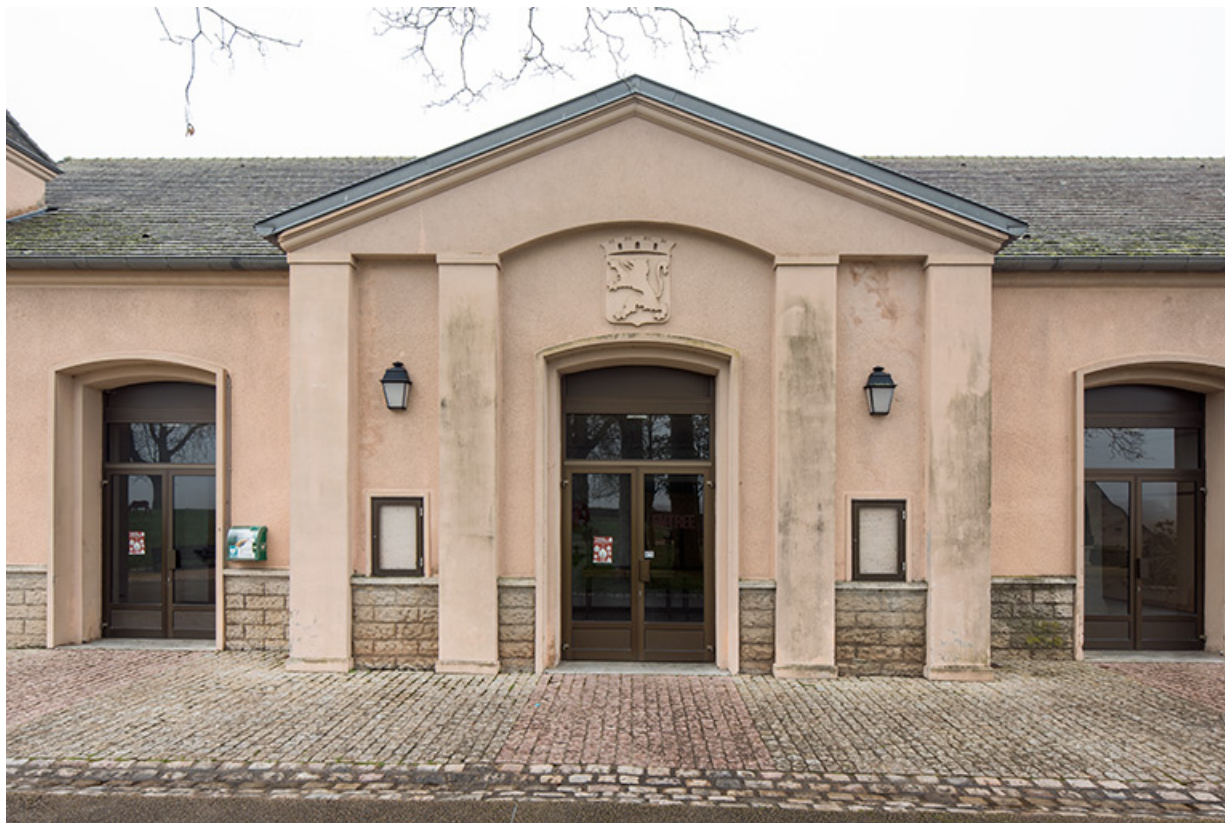
Façade antérieure : avant-corps central.
