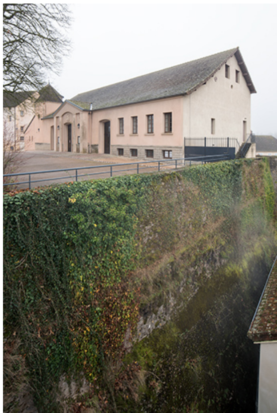
Façades antérieure et latérale droite.
