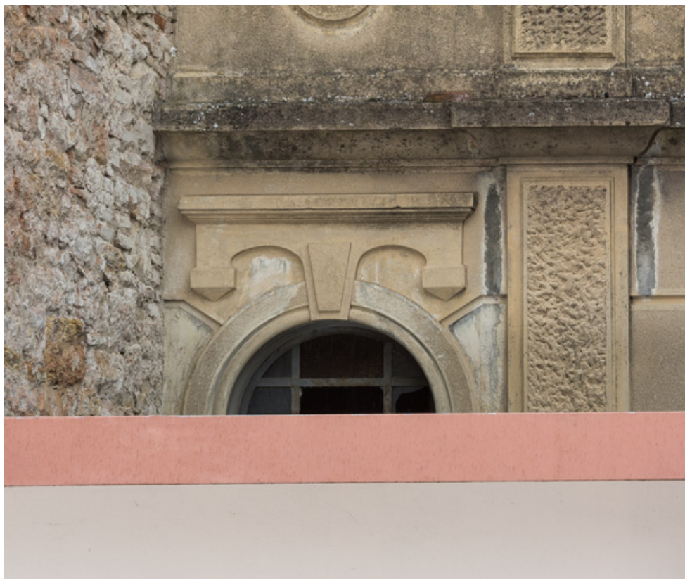
Façade antérieure : décor surmontant une fenêtre.
