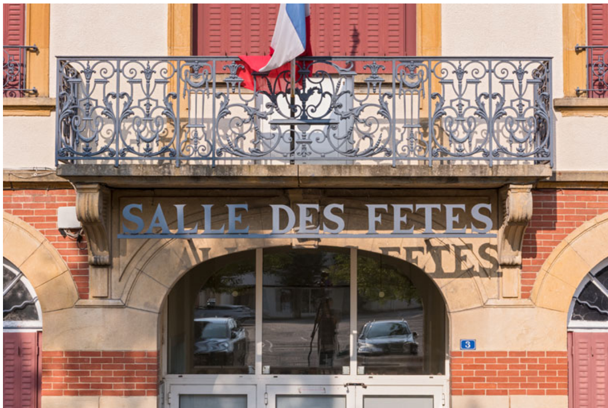
Façade antérieure : enseigne et balcon.
