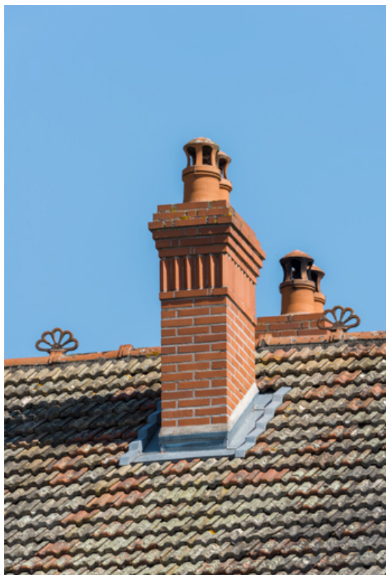
Hôtel-restaurant : souches de cheminée.
