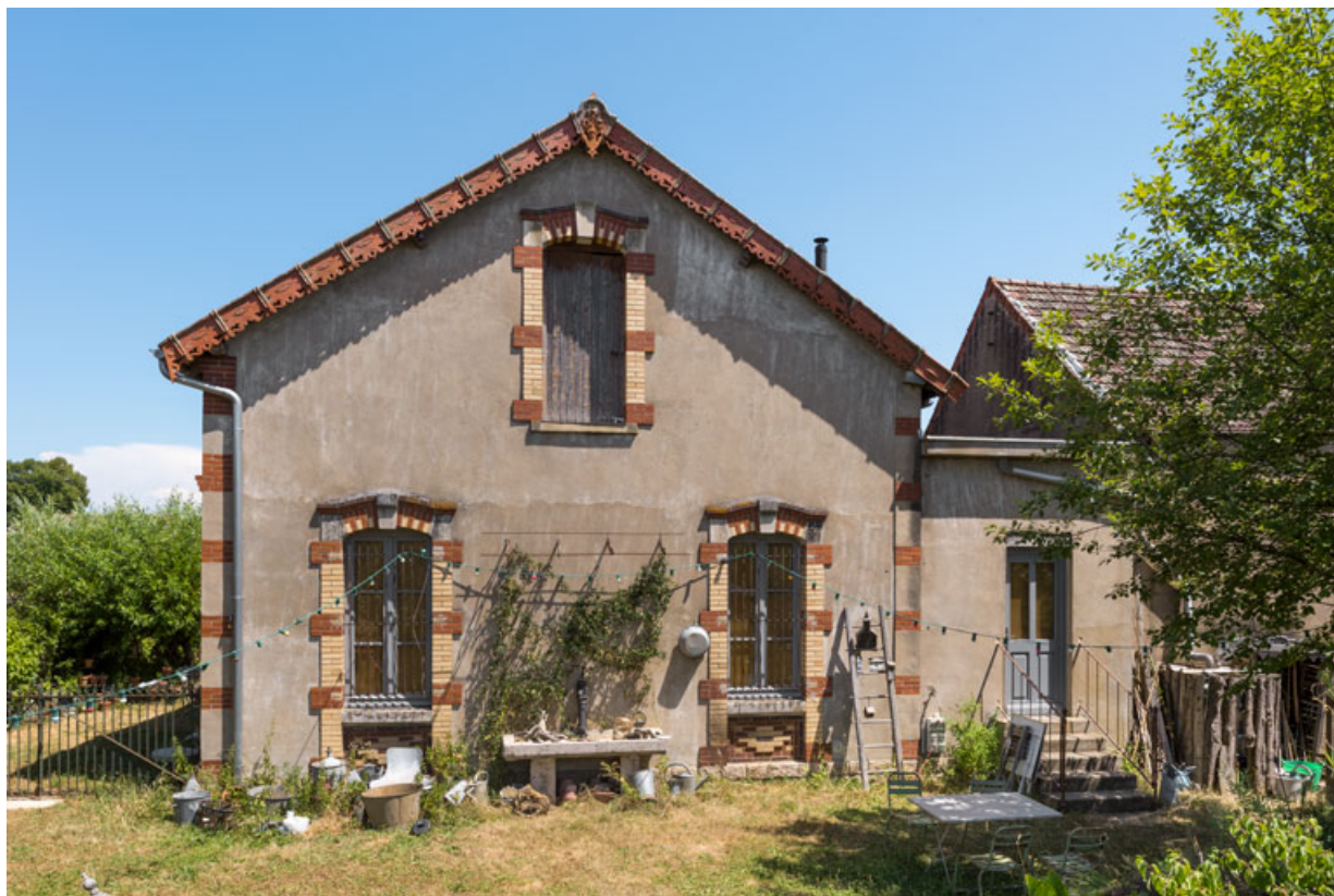
Salle de bal : façade latérale droite.
