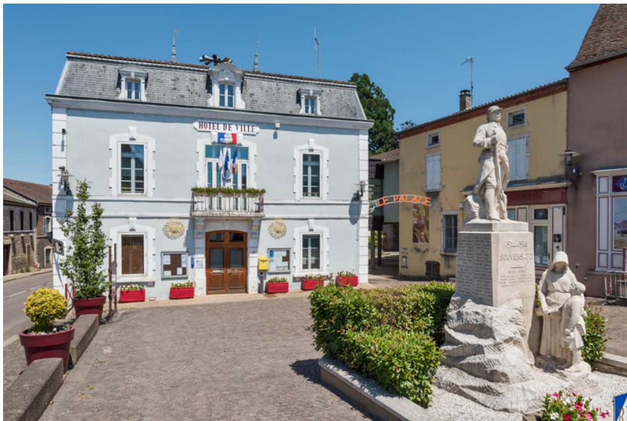
Vue d'ensemble, depuis la place d'Armes au sud : la mairie.
