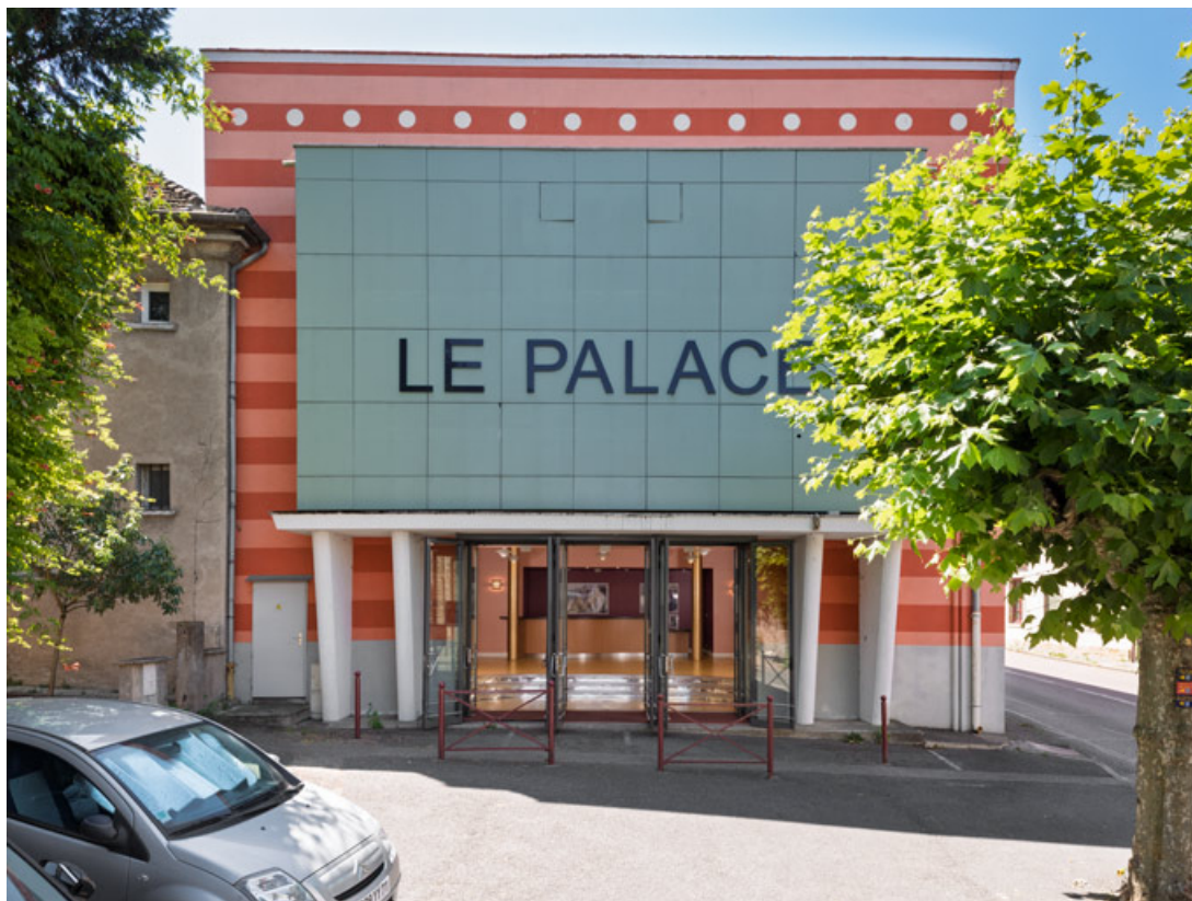
Salle de spectacle : façade antérieure.
