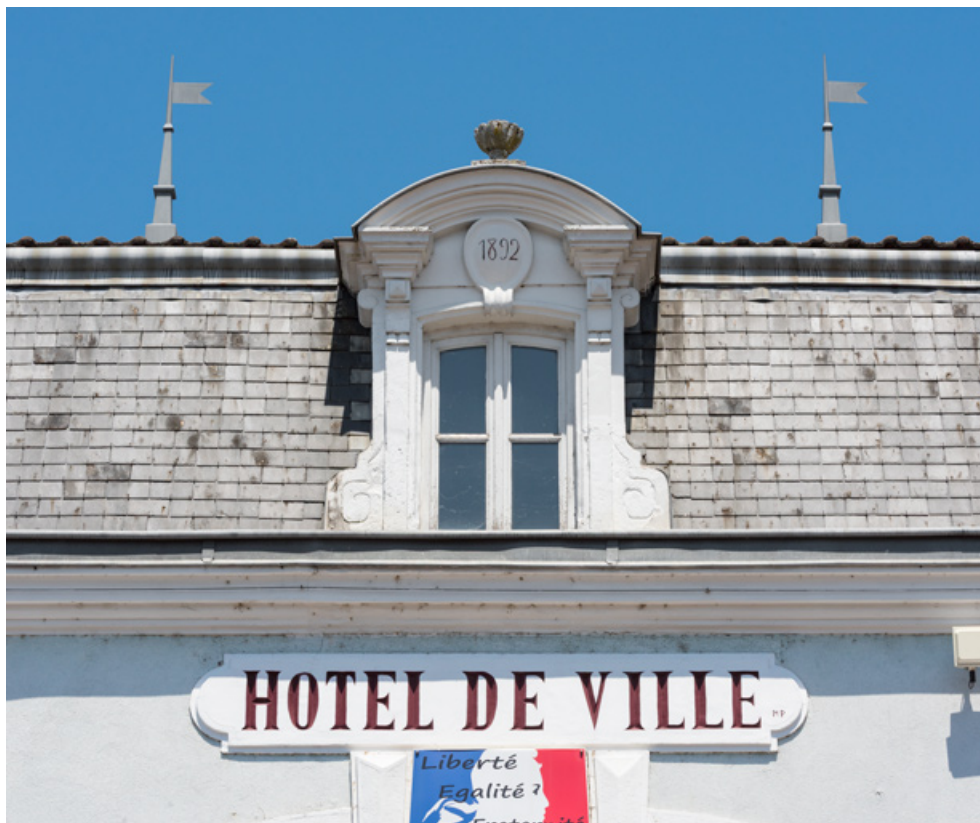
Mairie, façade antérieure : date portée sur la lucarne centrale. 71, Cuisery, 7 place d' Armes
