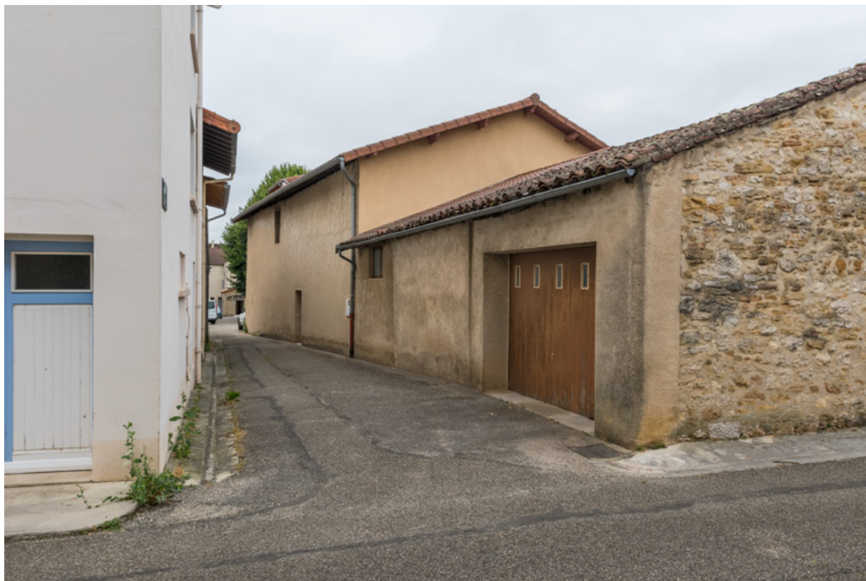
Façades postérieure et latérale droite.
