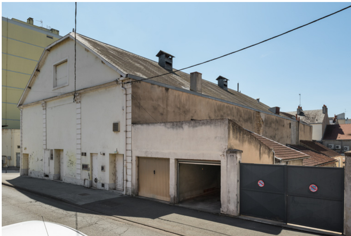
Cinéma : façades postérieure et latérale droite.
