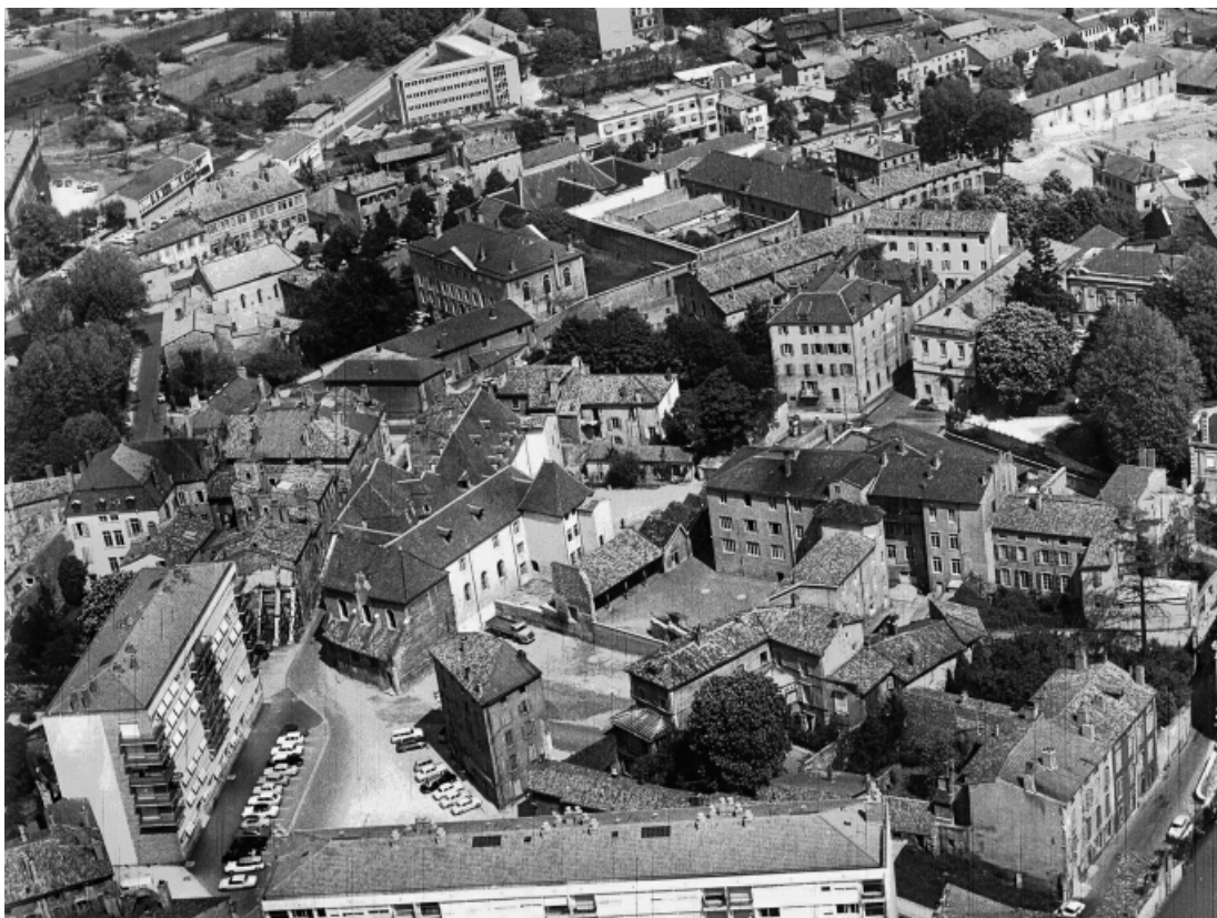
Vue aérienne du tribunal et de la prison de Mâcon (en haut). 71, Mâcon, 8 rue de la Préfecture
