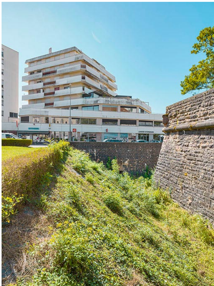
Le bastion Royal après restauration.
