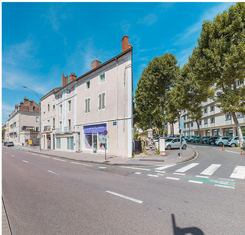
Avenue de Paris et vestige de l'ancienne courtine Saint-Pierre. 71, Chalon-sur-Saône
