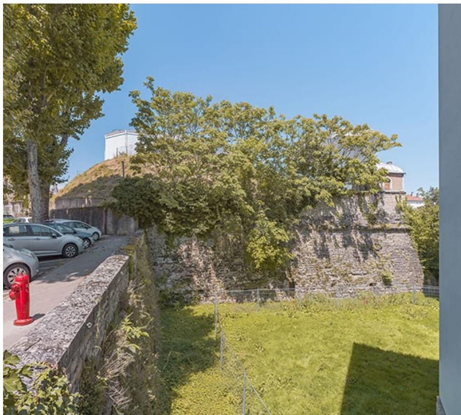
Vue sur le rempart Saint Vincent et le bastion Saint-Pierre. 71, Chalon-sur-Saône
