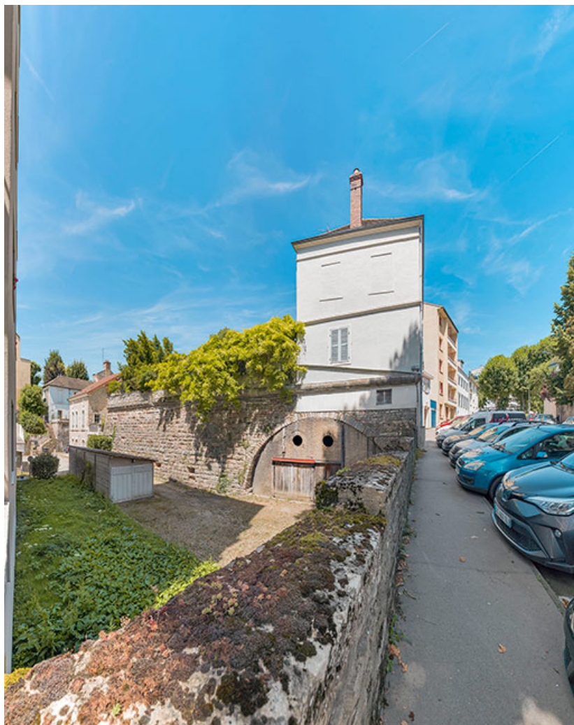
Flanc sud du bastion Saint-Paul.
