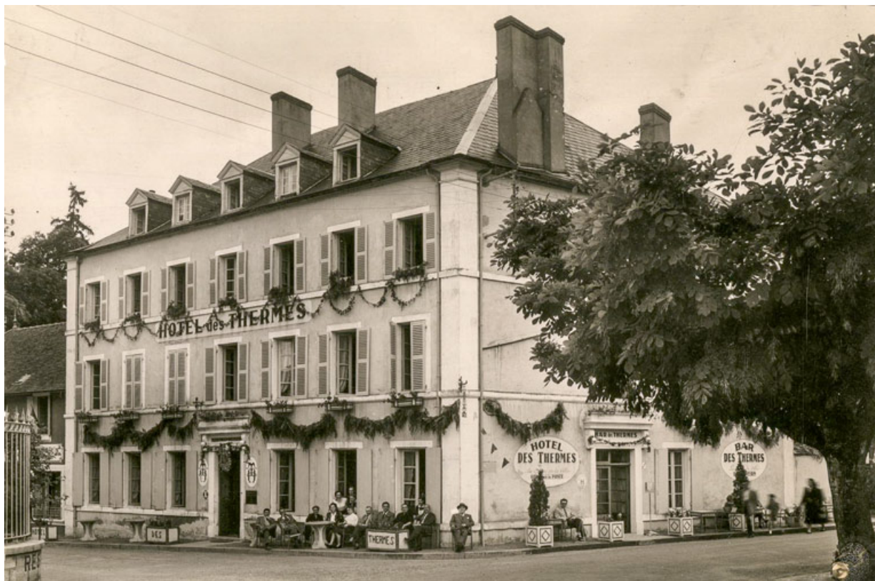
Vue ancienne (milieu du 20e siècle).
