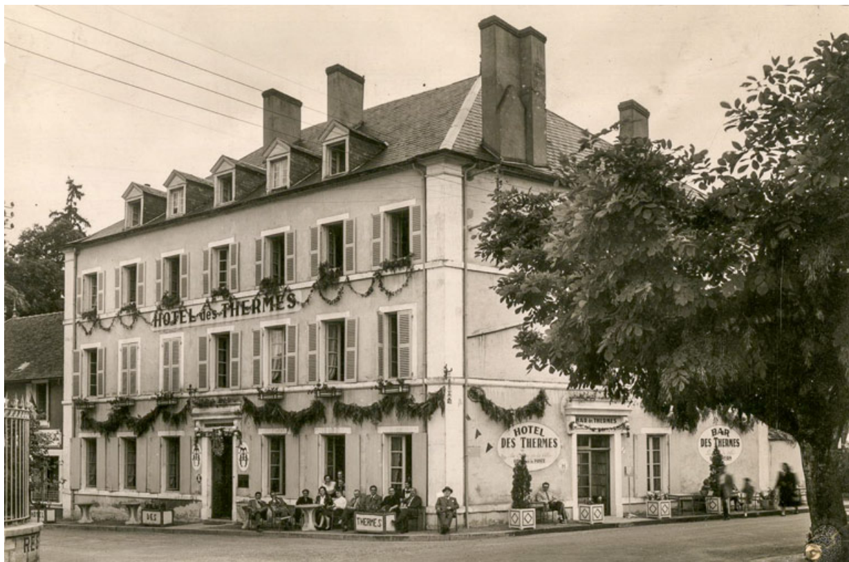
Vue ancienne (milieu du 20e siècle).
