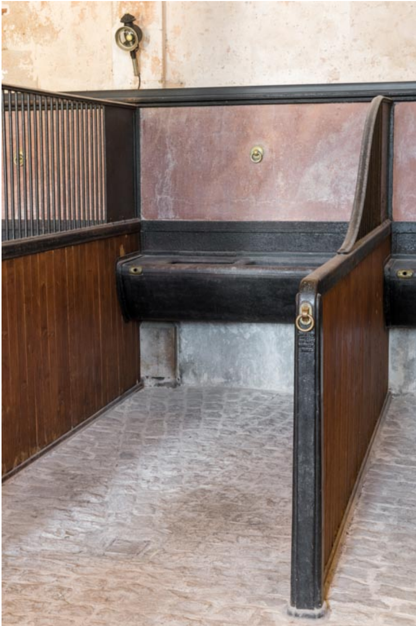
Rez-de-chaussée, salle centrale, stalles contre le mur nord-ouest, mangeoire.
