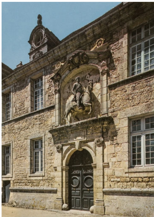
Travée centrale de la façade sud-est, vue avant restauration.
