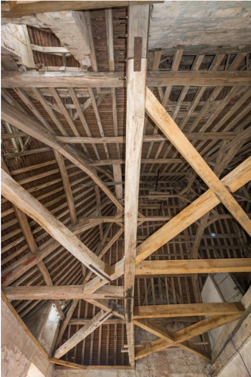
Charpente à chevrons portant-fermes, croupe sud-ouest, vue depuis le premier étage. 71, Saint-Bonnet-de-Joux chemin du Bois de Chaumont, lieudit : Château de Chaumont
