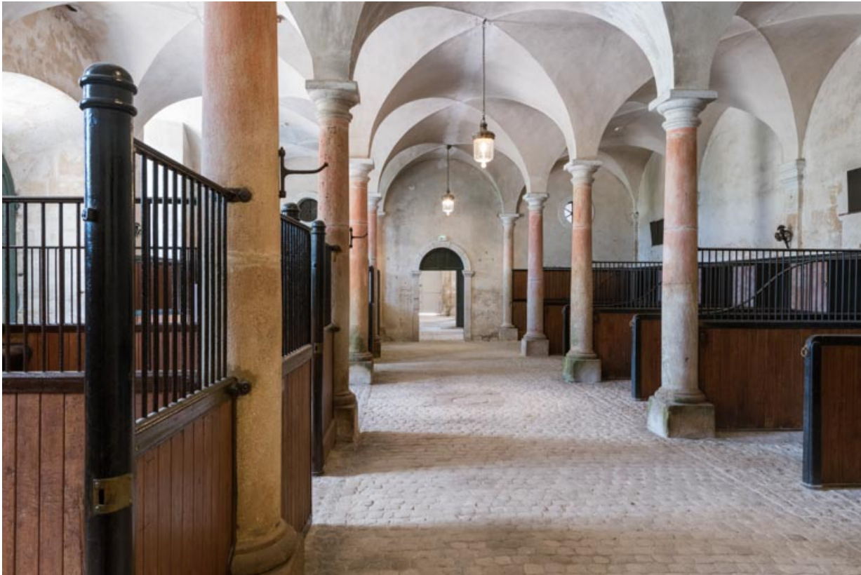
Rez-de-chaussée, salle centrale, vue en direction du sud-ouest.
