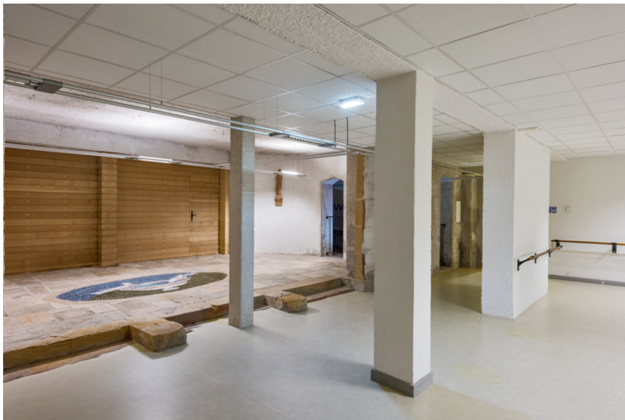
Niveau de l'ancienne piscine, sous-sol de la salle de spectacle actuelle (salle des associations).
