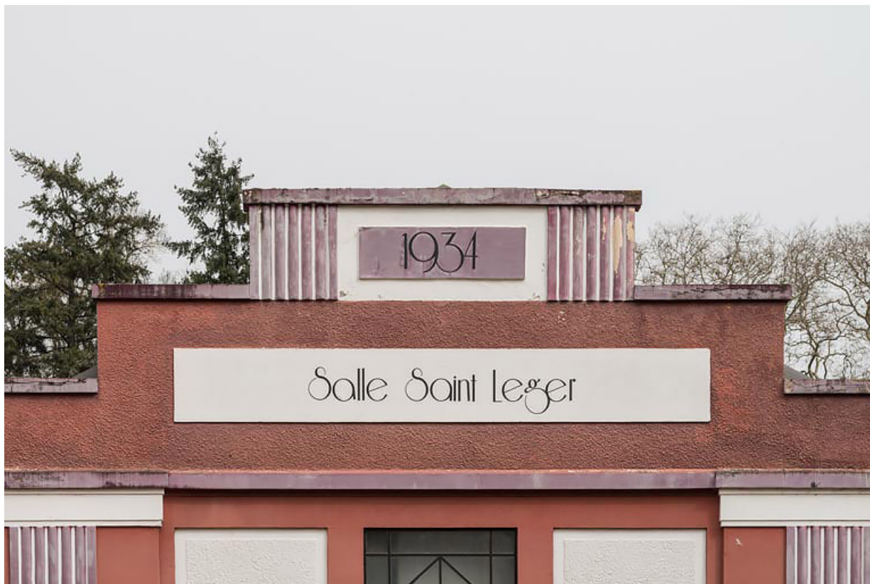
Façade, détail ("Salle Saint-Léger 1934"). 71, Bourbon-Lancy, 2 Parc thermal
