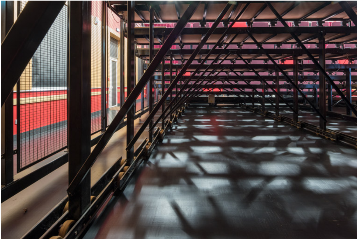
Gradin rétractable, vue de dessous.
