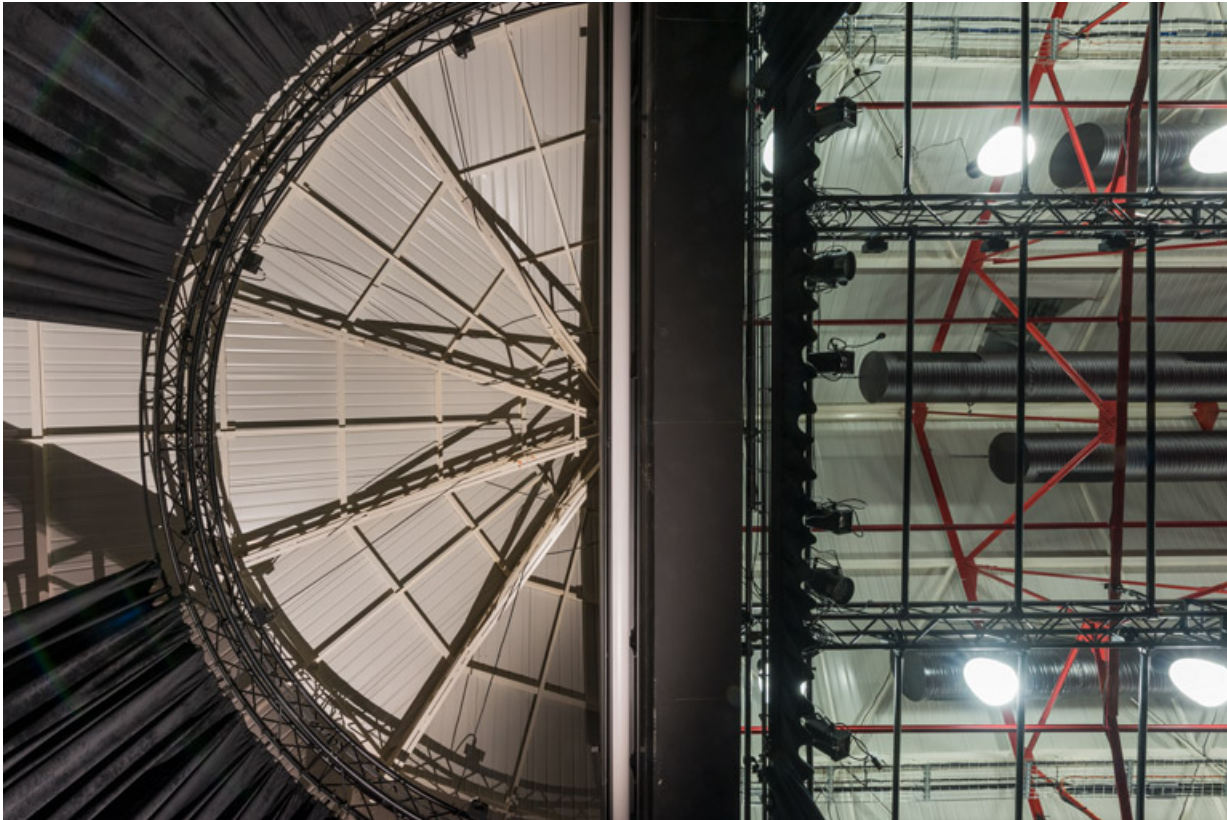
Charpente de la couverture, détail avec le mur du fond de scène.
